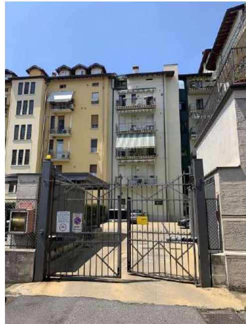
Accesso carraio al cortile pertinenziale del condominio
