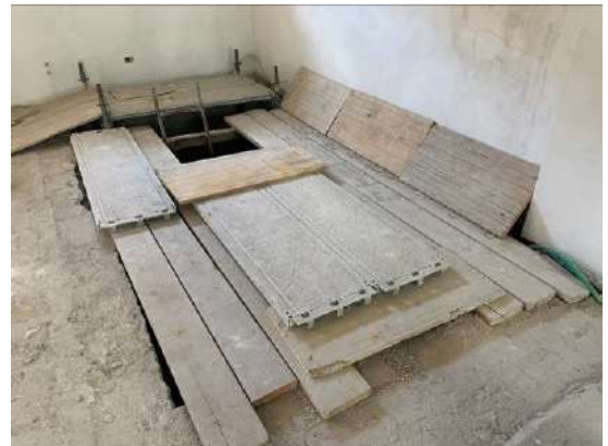
Foro per scala d'accesso al piano interrato
