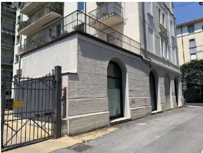
Prospetto est dell'edificio
