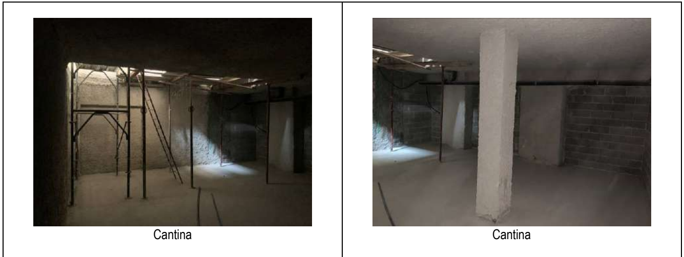
Figura 05: Immagini ambienti piano interrato
