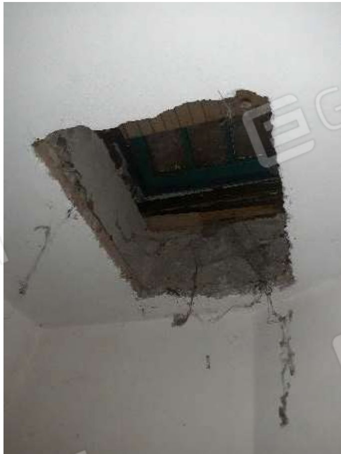
Lucernario lavanderia sotto cortiletto
