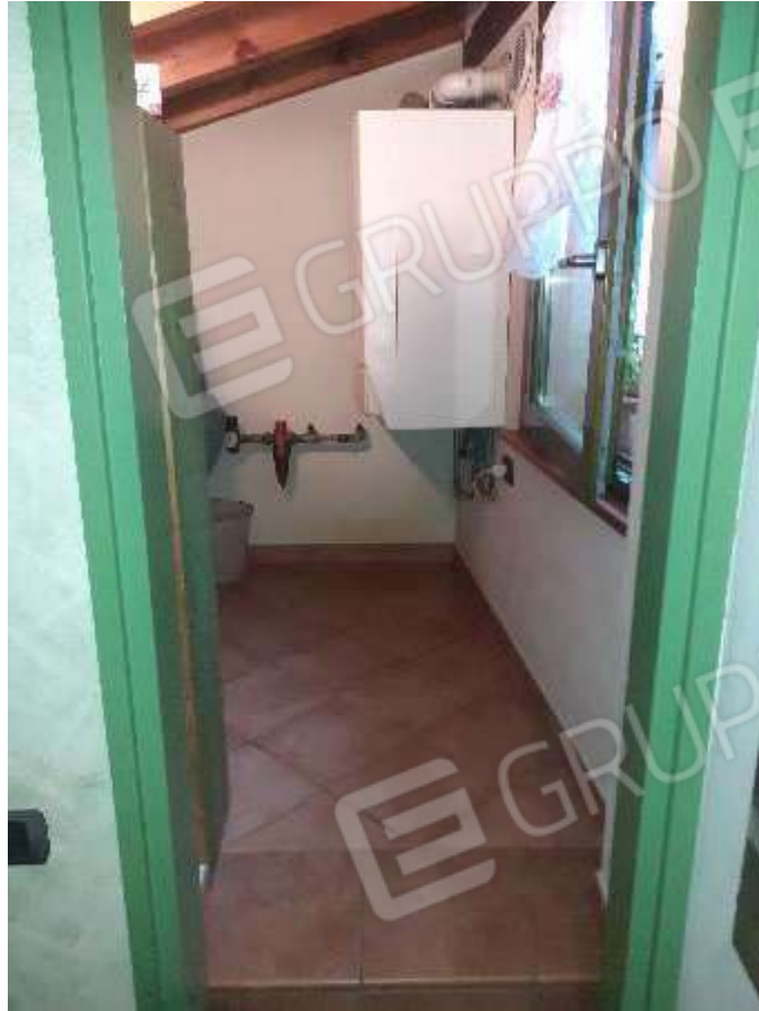
Locale tecnico sull'ammezzato scale
