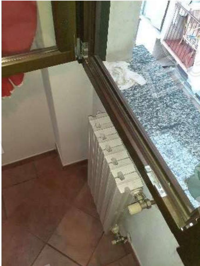
Dettaglio finestra e davanzale in granito
