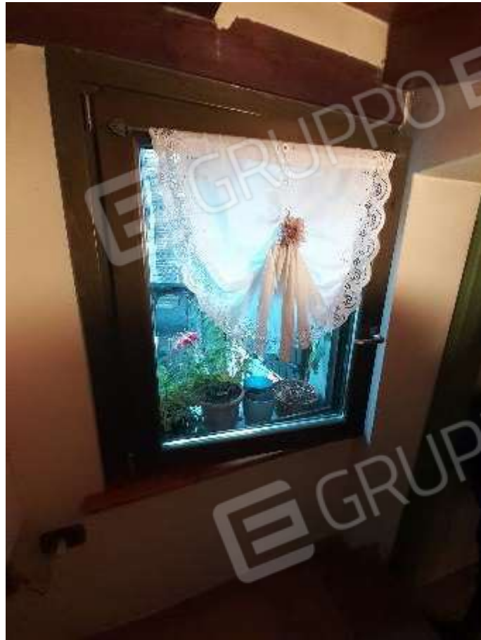
Finestra locale tecnico
