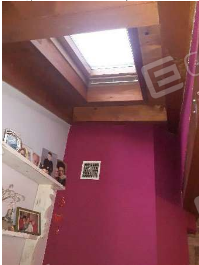
Lucernario porzione ribassata con tetto in legno
