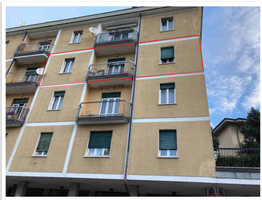
Foto 1- Vista del prospetto sud dalla via Monsuello sottostante
