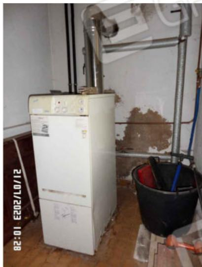
FOTO 42: Caldaia a basamento
