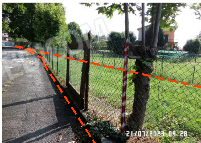
FOTO 6: Particolare della recinzione
