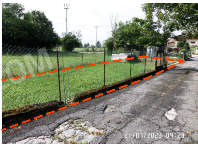
FOTO 4: Vista dalla diramazione interna di via Tesio
