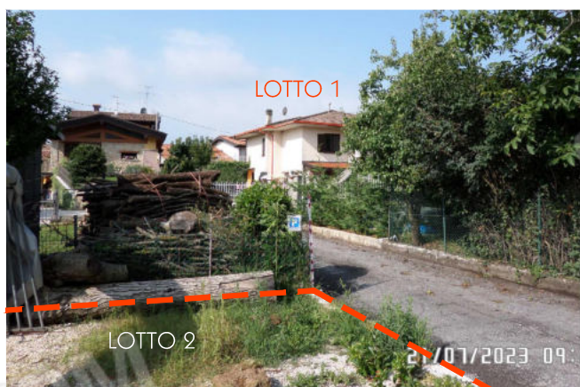
FOTO 10: Zona a parcheggio e ubicazione LOTTO 1
