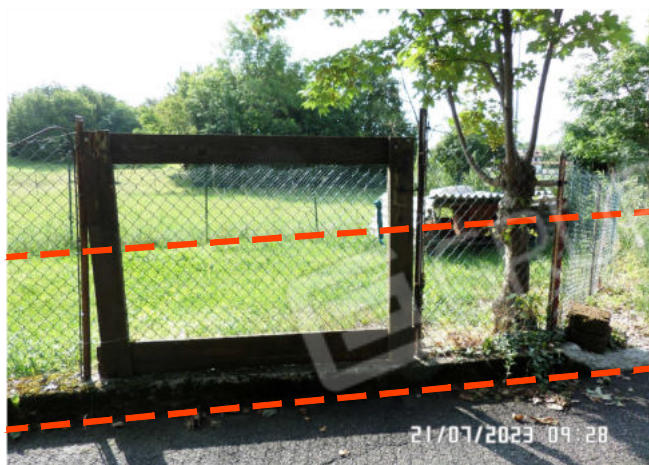
FOTO 7: Particolare del cancello di accesso al prato
