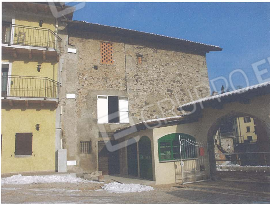
Fotografia esterna Lotto 1 p.terra Lotto 5 p.primo e p.secondo ingresso al lotto e locale caldaia del Lotto 2
