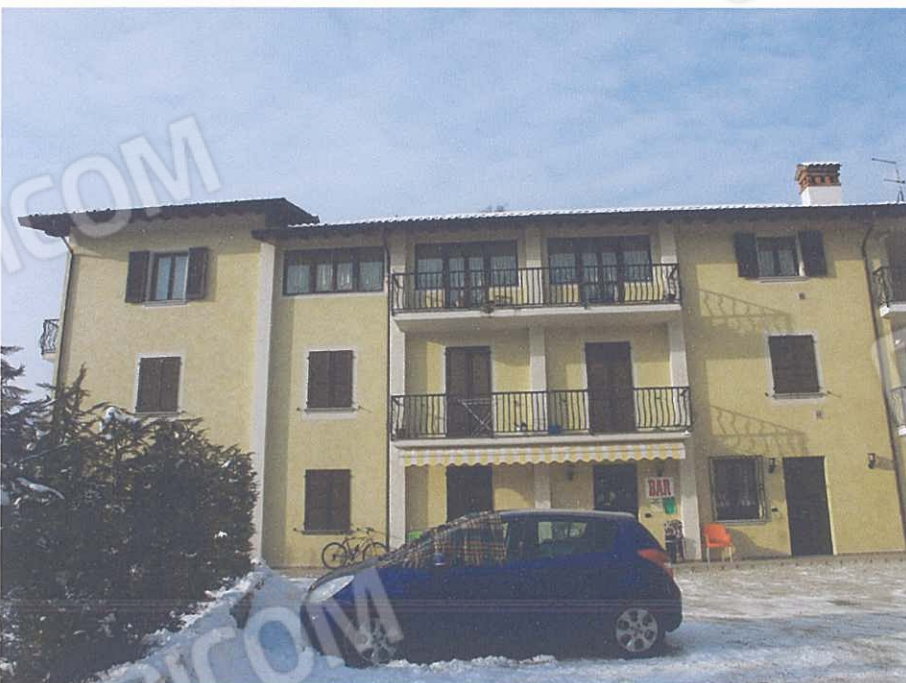
Fotografia esterna Lotto 4 p. primo Lotto 6 p.secondo Lotto 7 e 8 p. terra
