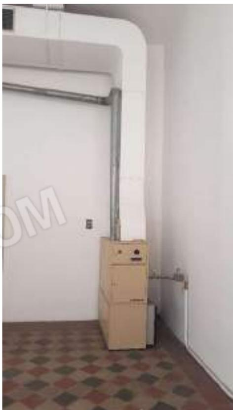
**FOTO 6 IMPIANTO DI RISCALDAMENTO AERAUICO IMISSIONE PIANO TERRA**
