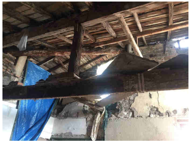
Foto 9 – Tetto visto dall'interno dell'unità.
