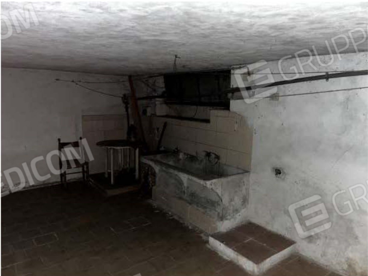
INTERRATO – LOCALE DI SGOMBERO
