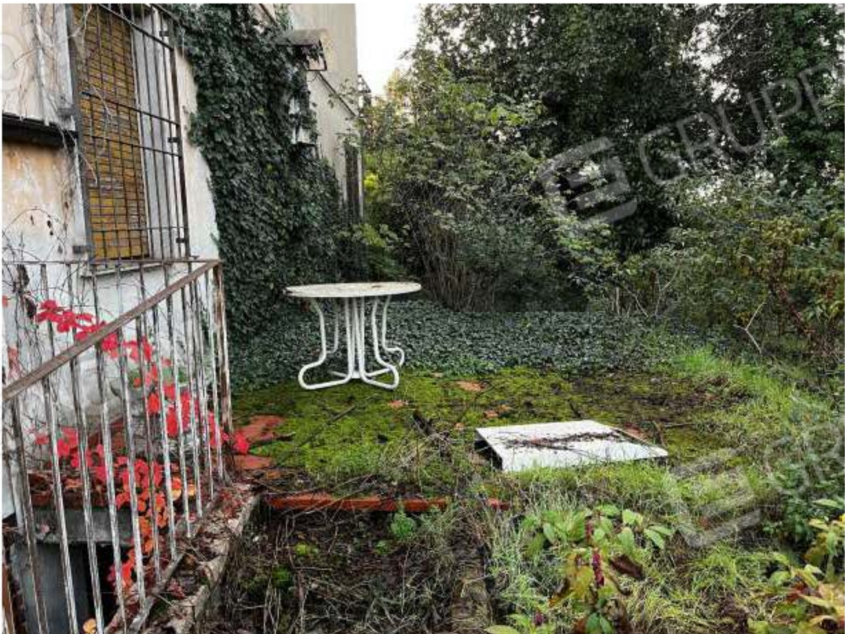
PAVIMENTO ESTERNO COMPLETAMENTE COPERTO DAL VERDE
