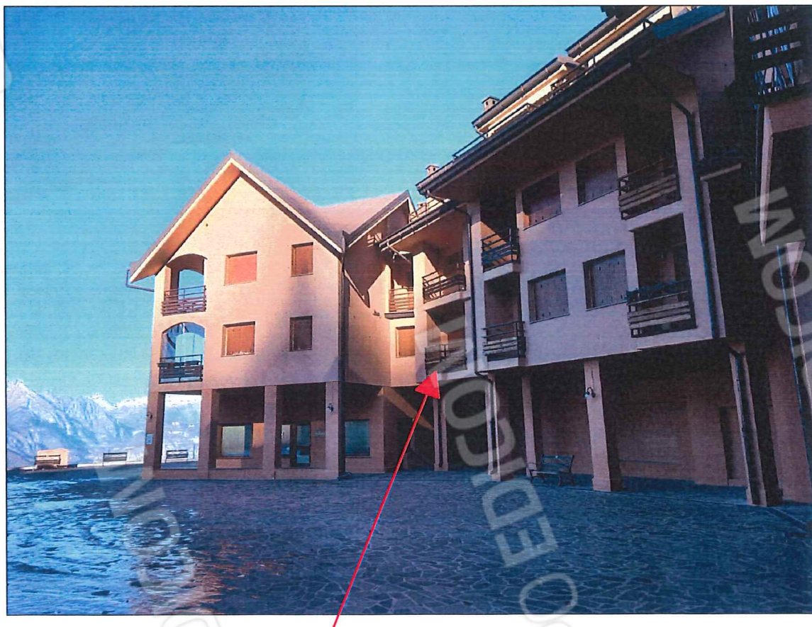
Ripresa fotografica dalla piazzetta esterna dell'immobile oggetto di stima foglio n. 29, particella n. 7553, sub. n. 20, Comune di Artogne (BS)
