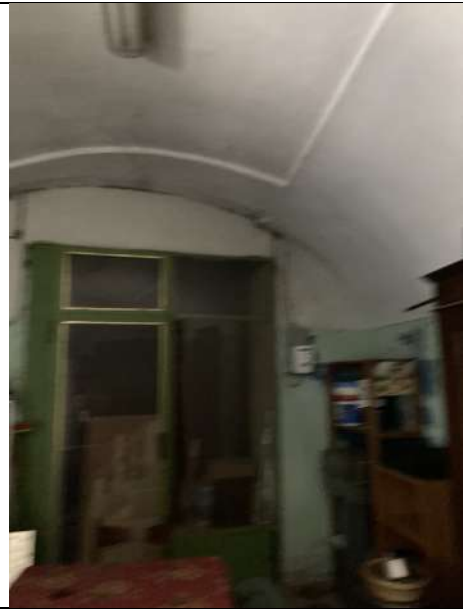
Foto 8_ Vista interna verso ingresso su via Fontane
