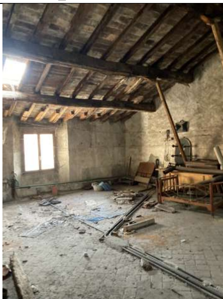
Foto 30_ Vista stanza 2 sottotetto
