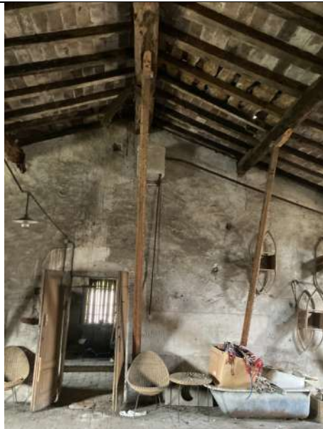
Foto 26_ Vista stanza 1 sottotetto
