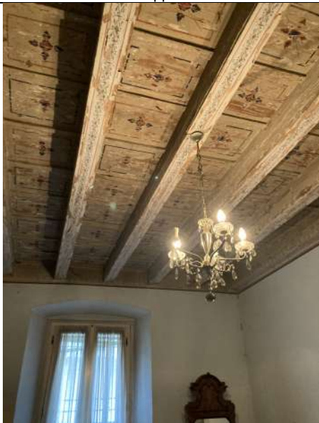
Foto 21_ Vista stanza centrale est P1
