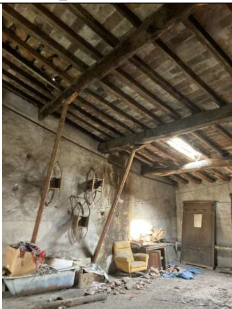
Foto 27_ Vista stanza 1 sottotetto
