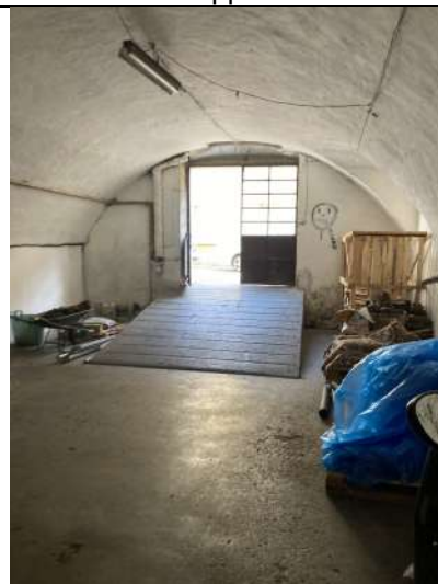
Foto 4_ Vista PT verso ingresso su Mapp.34
