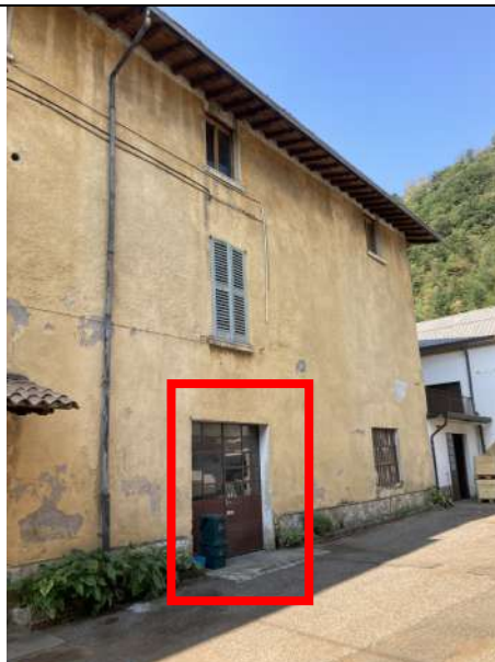
Foto 2_ Vista ingresso al Piano Terra da corte Mapp.34
