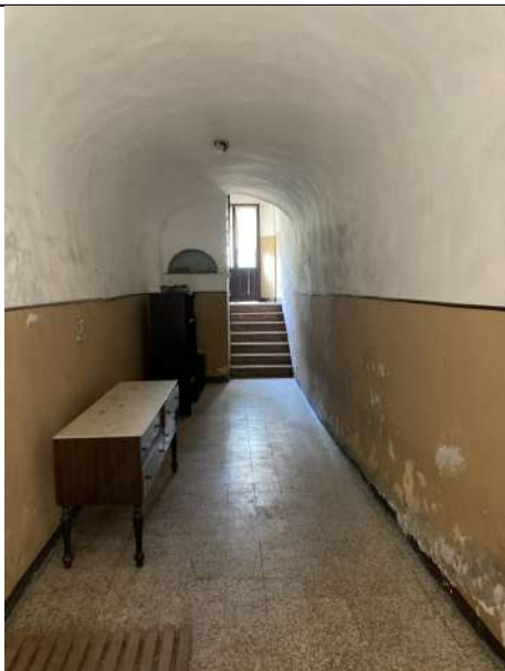
Foto 7_ Vista corridoio ingresso ai P1 e sottotetto
