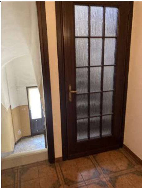
Foto 23_ Vista porte vano scala P1
