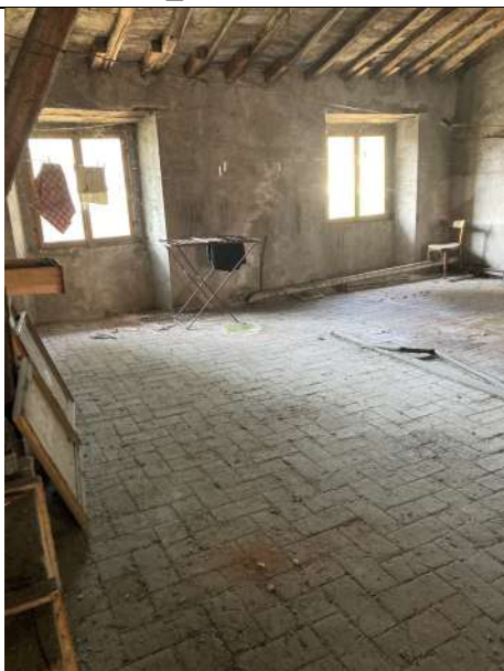
Foto 29_ Vista stanza 2 sottotetto
