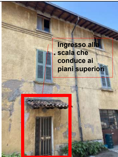
Foto 1_ Vista immobile da corte Mapp.34
