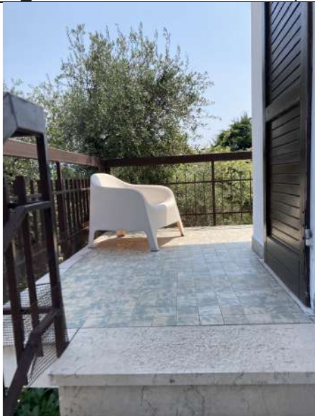
Foto 3_Vista accesso al balcone
