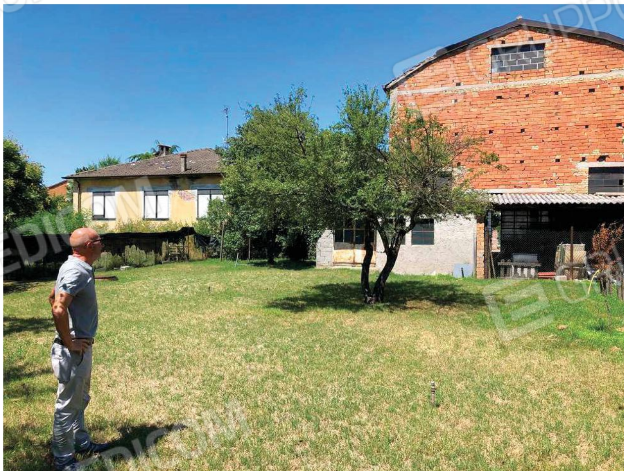
ESTERNO VISTA DA AREA CORTIVA A PRATO
