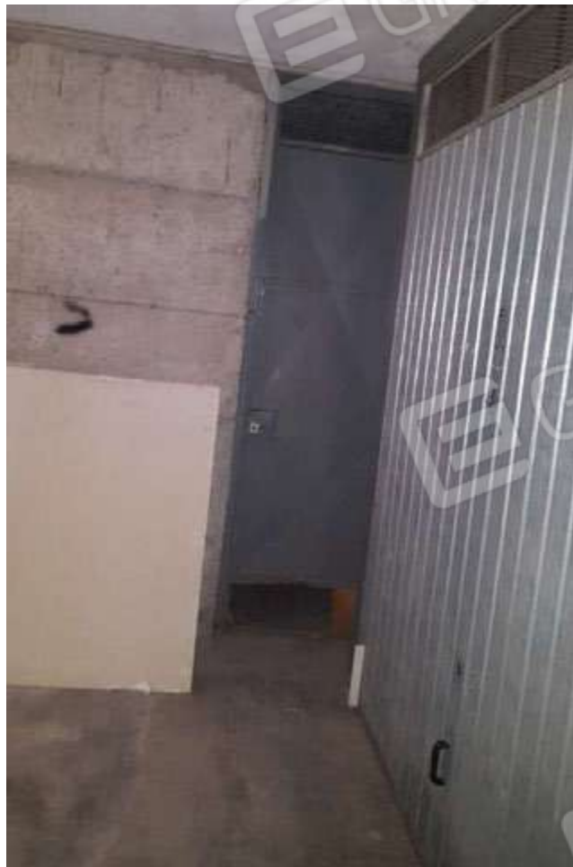
Immagine 10 - Part. 4063 Sub. 6. Cantina.
