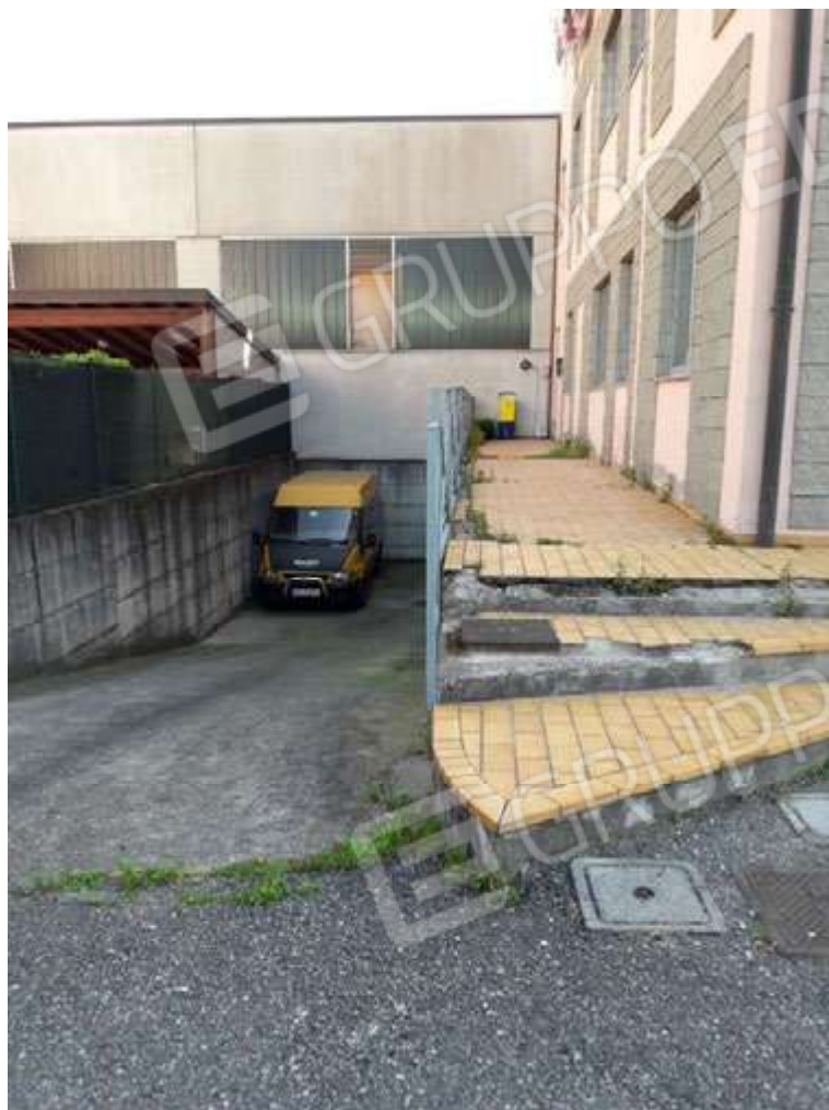
Immagine 3 - Vista della rampa di accesso al piano seminterrato e del ballatoio al piano terra.
