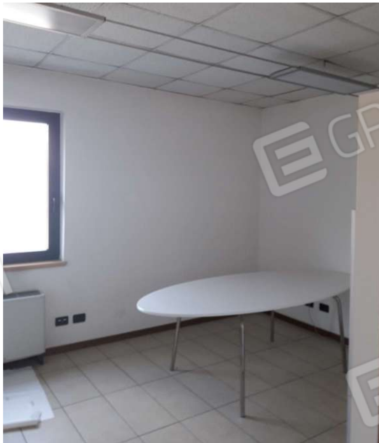
Immagine 8 - Part. 113 Sub. 23. Ufficio lato Ovest.
