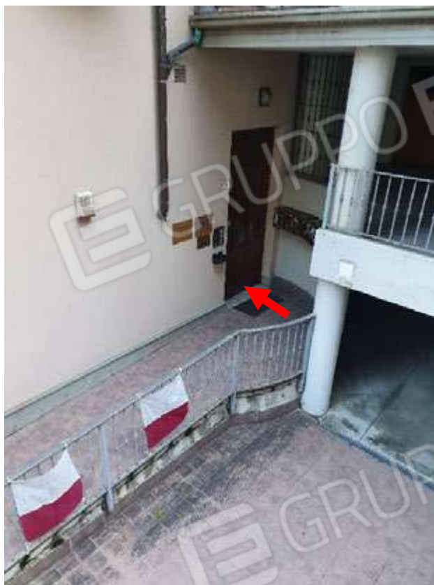
Immagine 3 - Vista da Via Pelabrocco. In evidenza l'ingresso al vano scala comune al piano terra.
