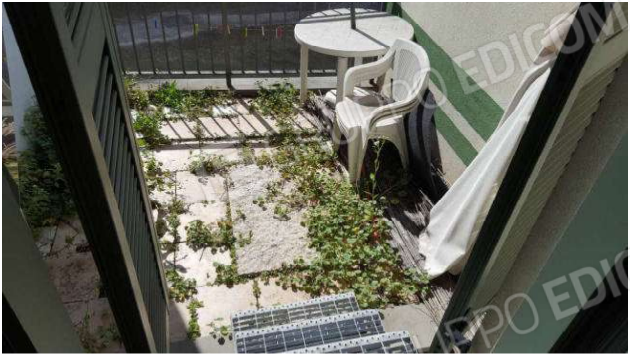
Immagine 10 - Part. 13499 Sub. 2. Terrazzino accessibile dalla camera da letto.
