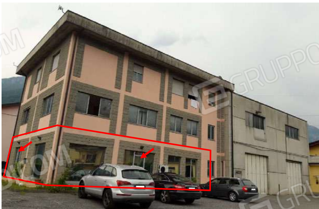
Immagine 16 - Part. 4063 Sub. 10. In evidenza l'unità immobiliare in esame con indicati i due accessi lungo il lato Sud ed il lato Ovest.
