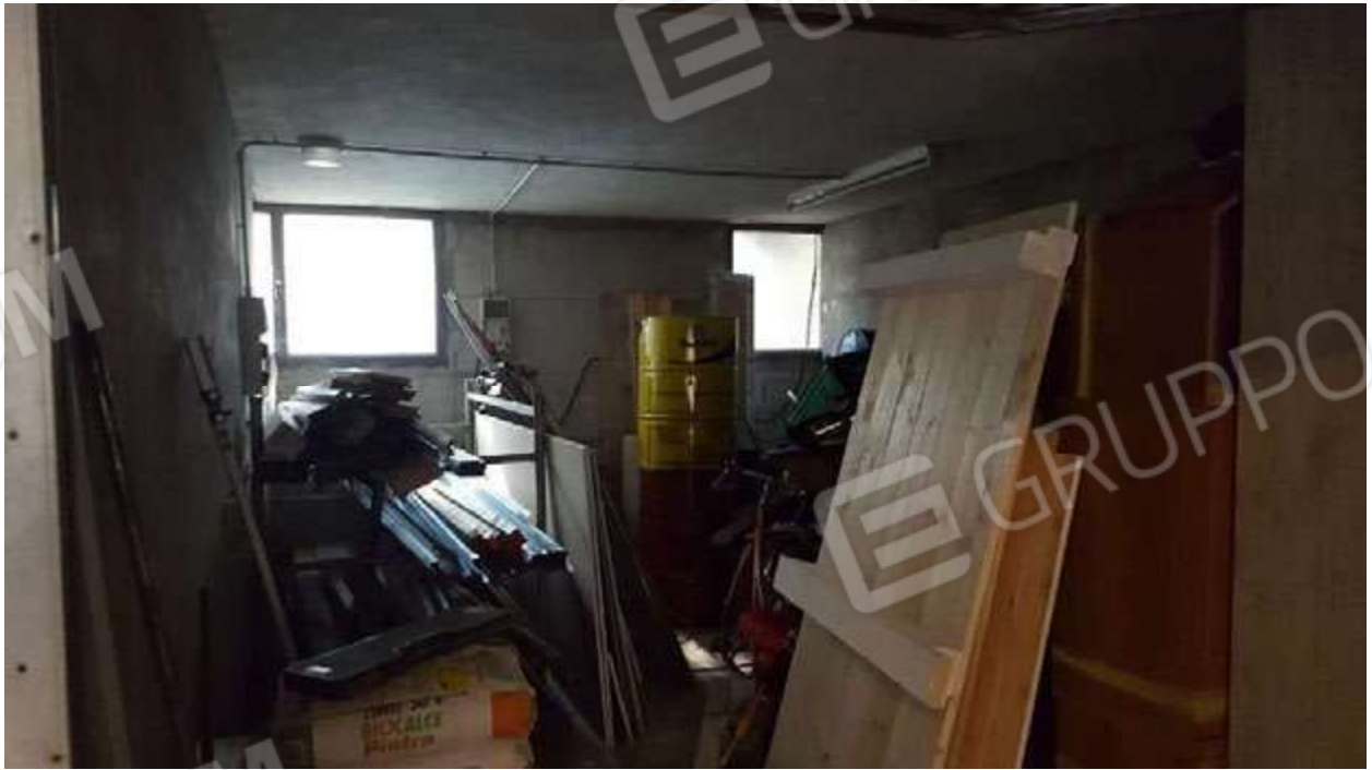
Immagine 8 - Part. 4063 Sub. 4. Autorimessa.
