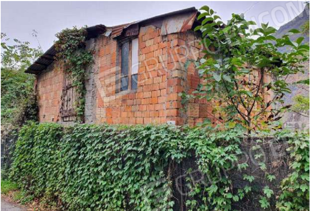
Immagine 13 - Particella 5219, vista da Nord-Est. In primo piano il fabbricato in blocchi di laterizio.
