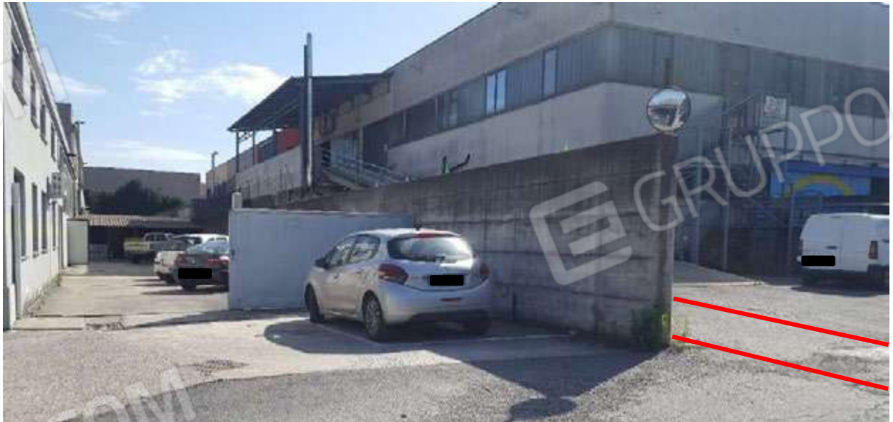
Immagine 2 - Vista da Via Dossi. In evidenza la posizione in cui dovrebbe trovarsi l'unità immobiliare contraddistinta dal subalterno 6.
