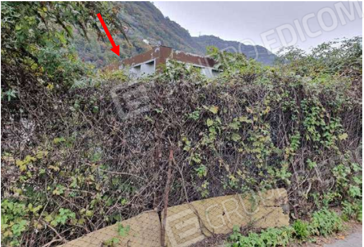
Immagine 9 - Particella 5219, vista da Est. In evidenza una baracca metallica visibile dalla strada.
