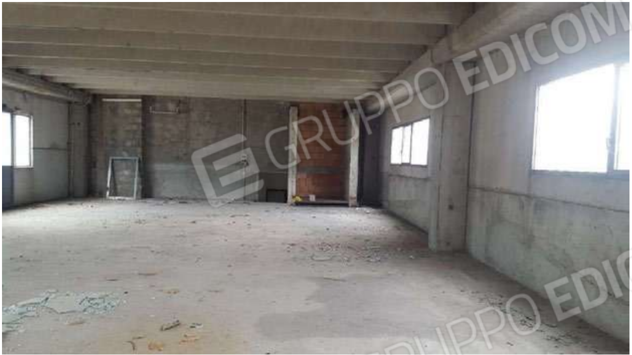
Immagine 33 - Part. 4063 Sub. 11. Porzione di capannone vista da Ovest.
