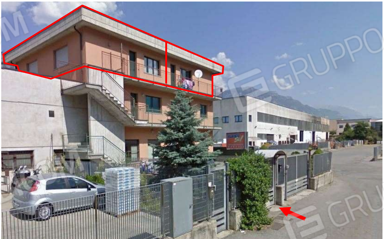
Immagine 2 - Vista da Via Dossi: in evidenza la palazzina con due delle unità immobiliari oggetto di perizia (sub. 8 e 9) ed il cancello pedonale d'ingresso alla corte comune.
