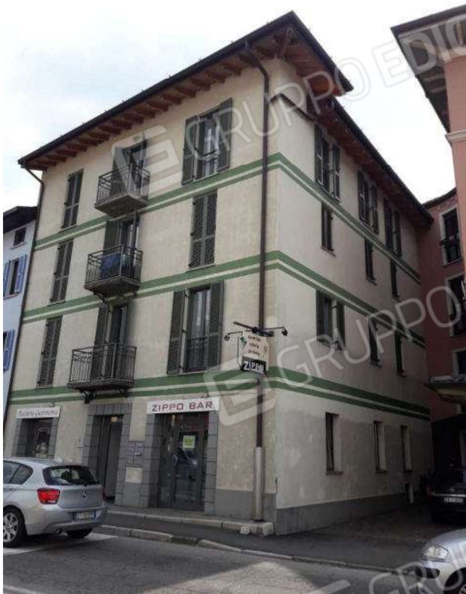
Immagine 3 - Vista da Sud-Ovest.
