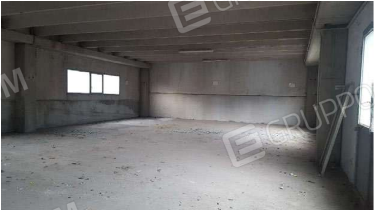
Immagine 32 - Part. 4063 Sub. 11. Porzione di capannone vista da Ovest.
