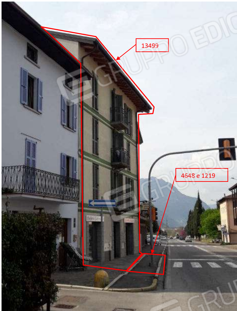
Immagine 2 - Vista da Nord. Individuazione delle particelle 4648, 1219 e 13499.
