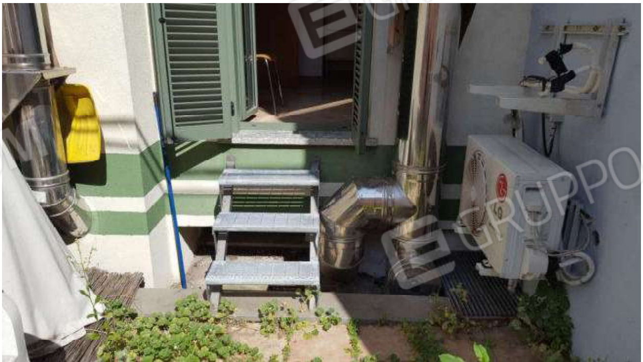
Immagine 11 - Part. 13499 Sub. 2. Terrazzino accessibile dalla camera da letto.
