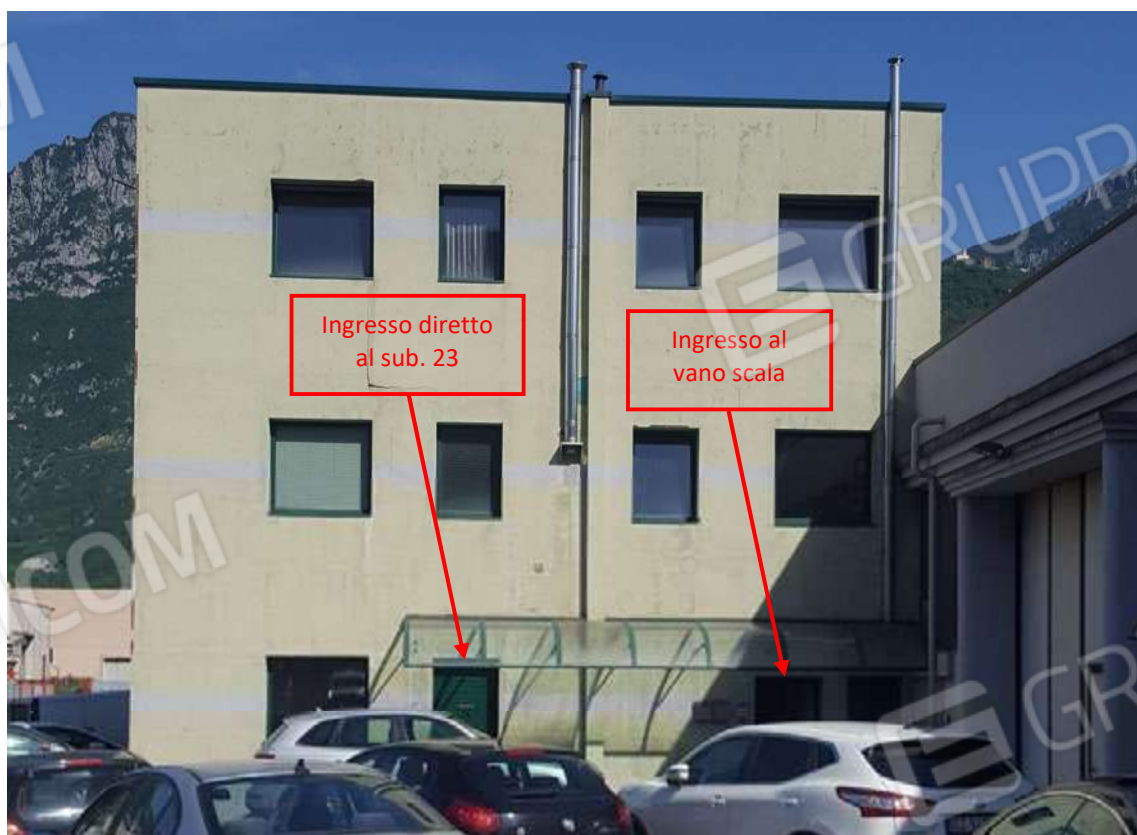
Immagine 4 - Palazzina uffici. In evidenza l'ingresso diretto al subalterno 23 e l'ingresso al vano scala comune.
