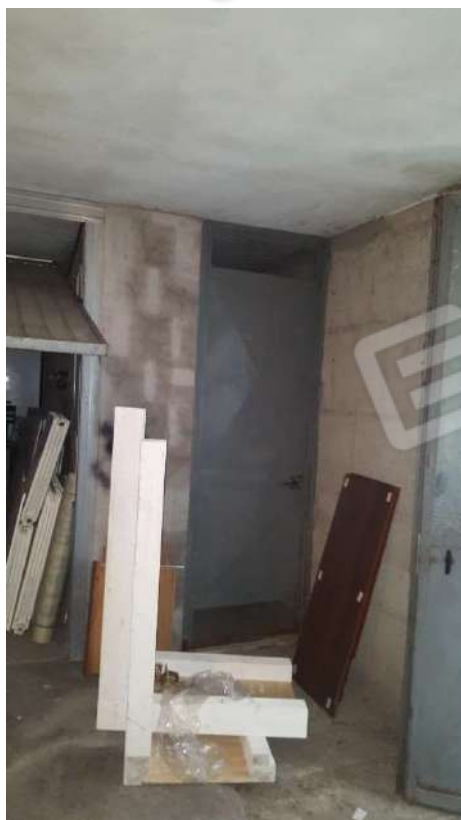
Immagine 6 - Part. 4063 Sub. 2. Porta di accesso alla cantina.
