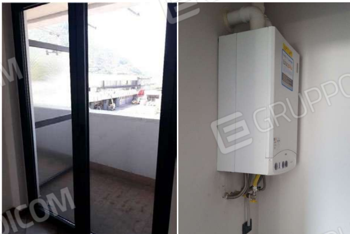
Immagine 26 - Part. 113 Sub. 26. A sinistra, terrazzino; a destra, caldaia.
