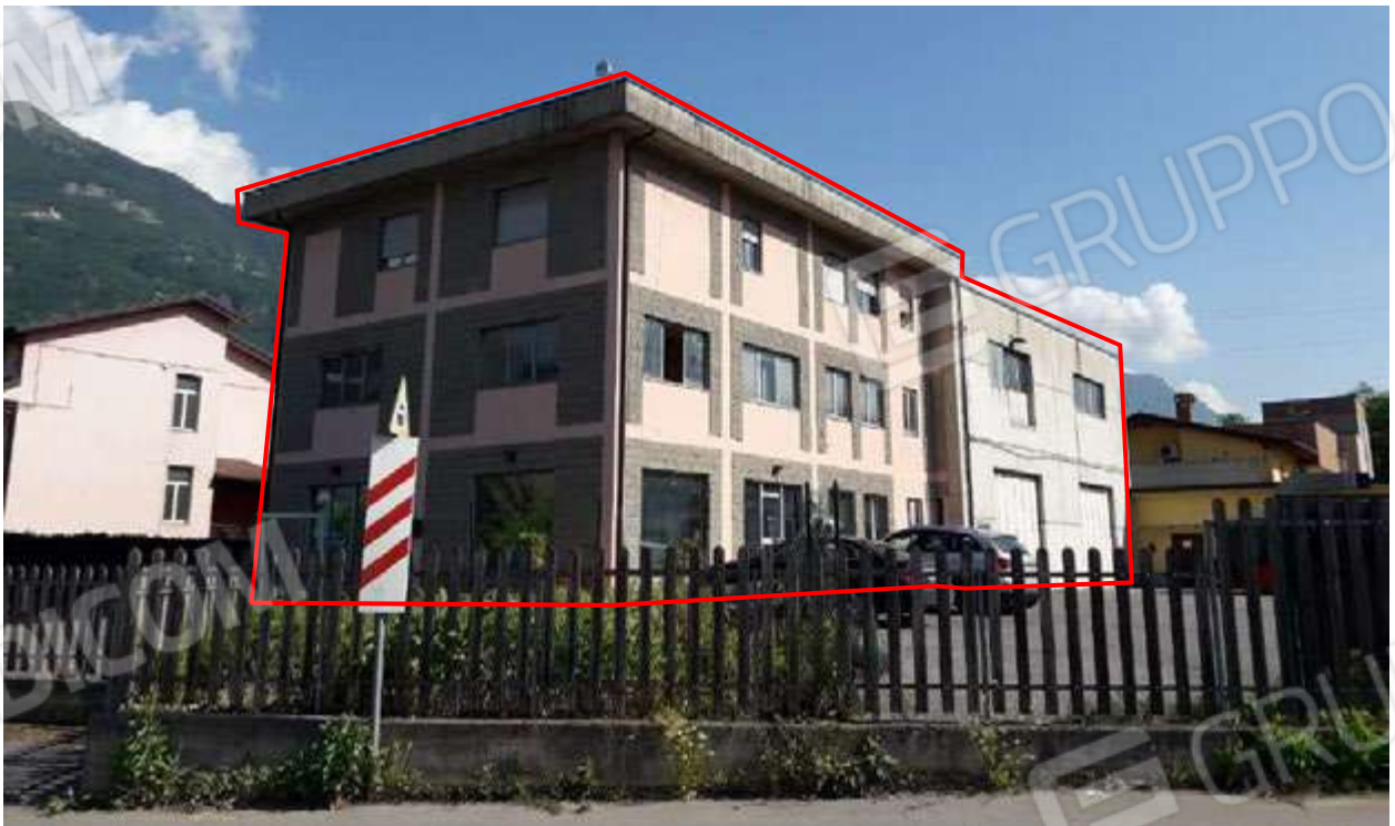
Immagine 2 - Vista da Via Puccini: in evidenza la palazzina ed il capannone al cui interno sono distribuite le unità immobiliari oggetto di perizia.
