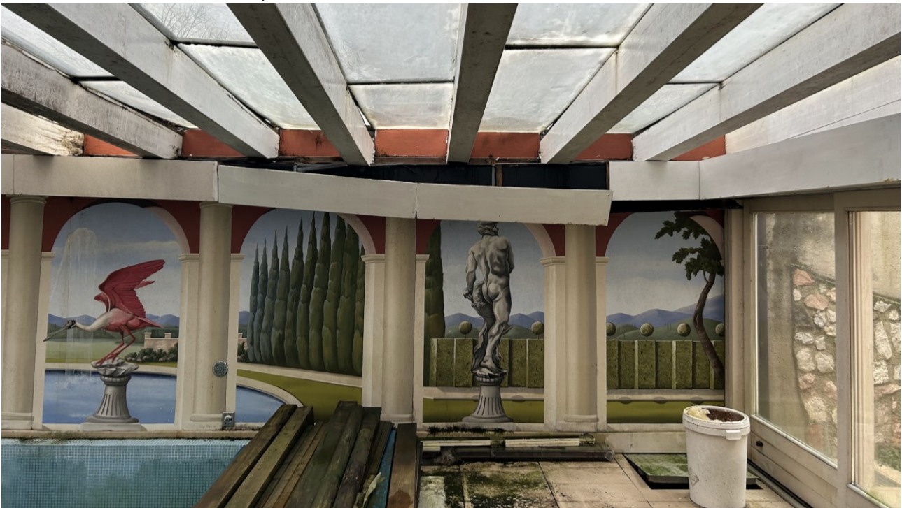
FOTOGRAFIA PISCINA COPERTA, CEDIMENTO TRAVATURA DI COPERTURA.
