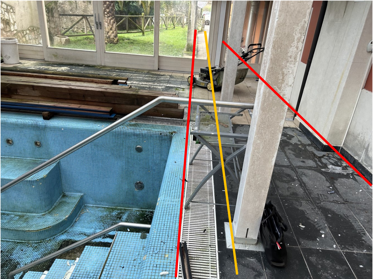
FOTOGRAFIA PISCINA COPERTA, CEDIMENTO TRAVATURA DI COPERTURA.
