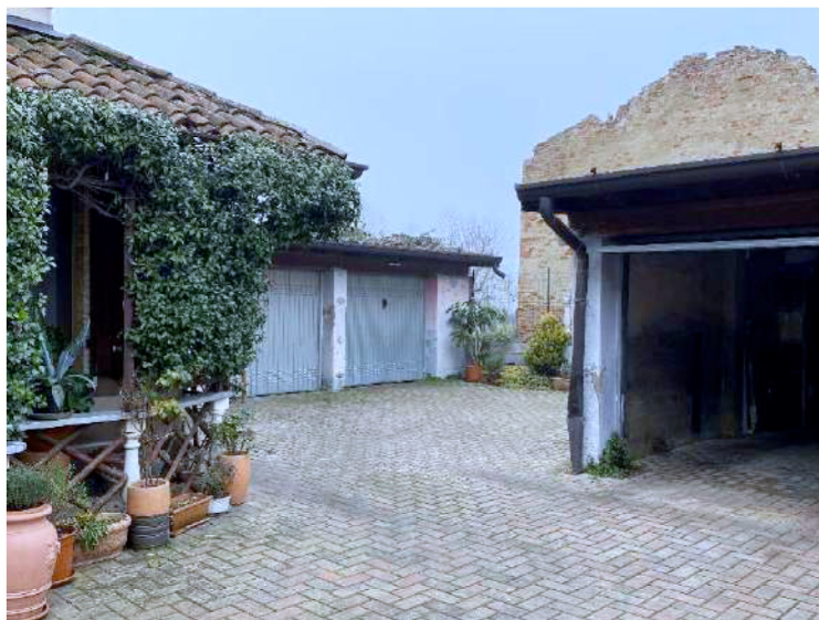
Foto 10 - 12) Particolari del cortile e dei fabbricati per le autorimesse
