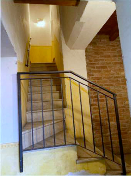
Foto 9) Il vano scala della “Scala 3”
