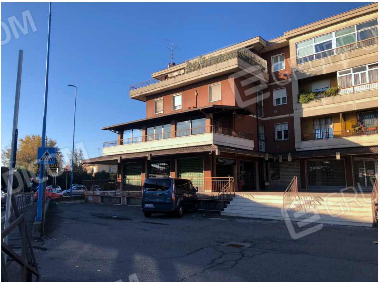
Foto n°2: Vista fronte est del fabbricato
