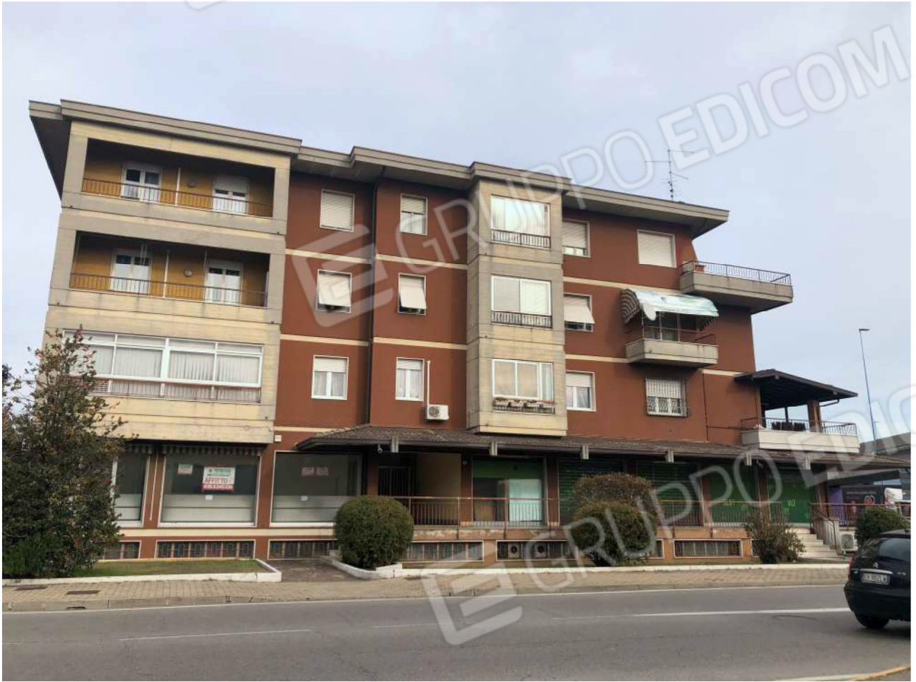
Foto n°1: Vista del fronte sud del fabbricato
