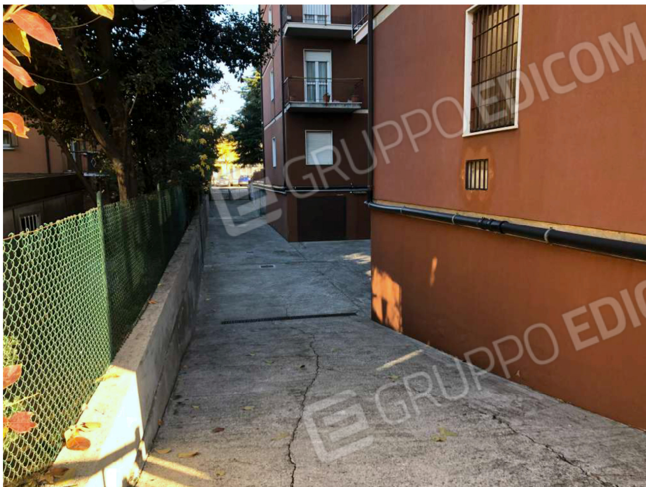
Foto n°23: Rampa d'accesso al cortile comune
