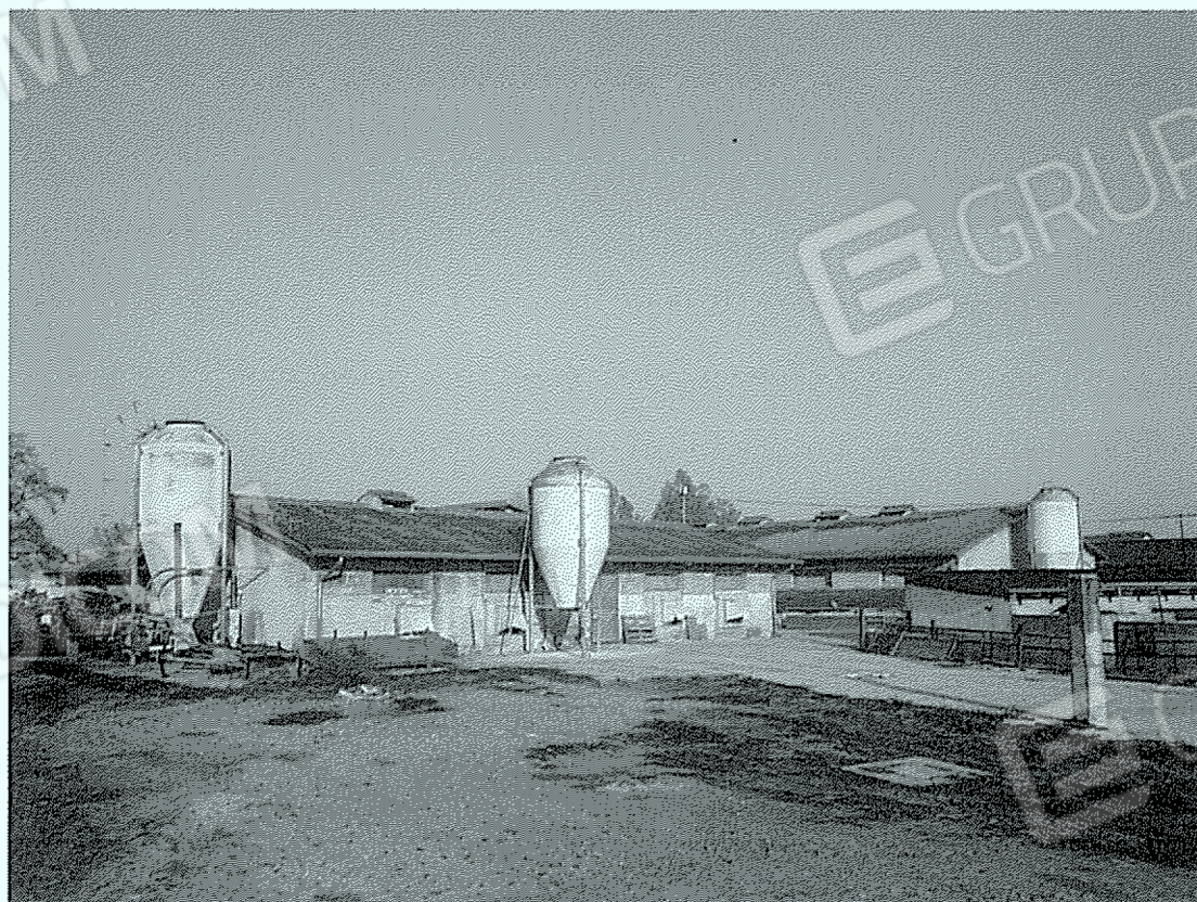
Corpo "7" (sulla sinistra), e Corpi "6" e "9" (sulla destra)
