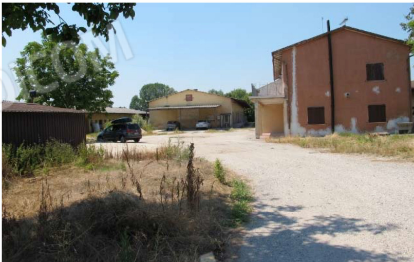
Vista servitù di passaggio su terreni di altra proprietà per l'accesso alla Stalla Fabbricato Ae Locale Pesa Fabbricato C
