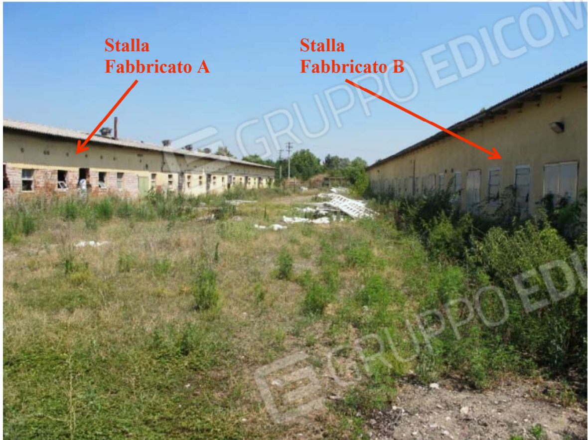
Viste cortile interno comune tra le stalle
