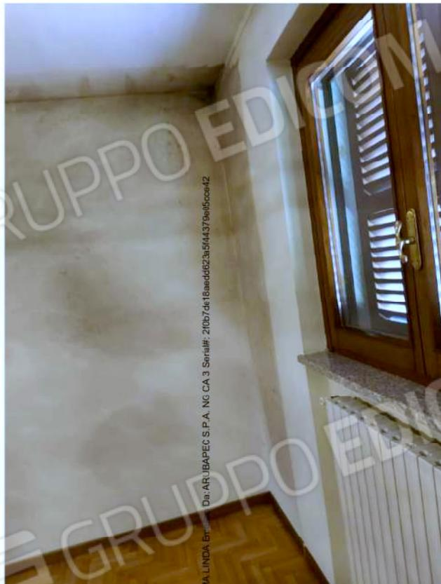
Camera visibili le tracce di ponte termico e infiltrazioni
