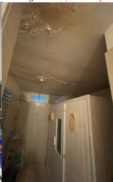
Bagno-Sauna (N.B. sono presenti infiltrazioni dal soffitto)
