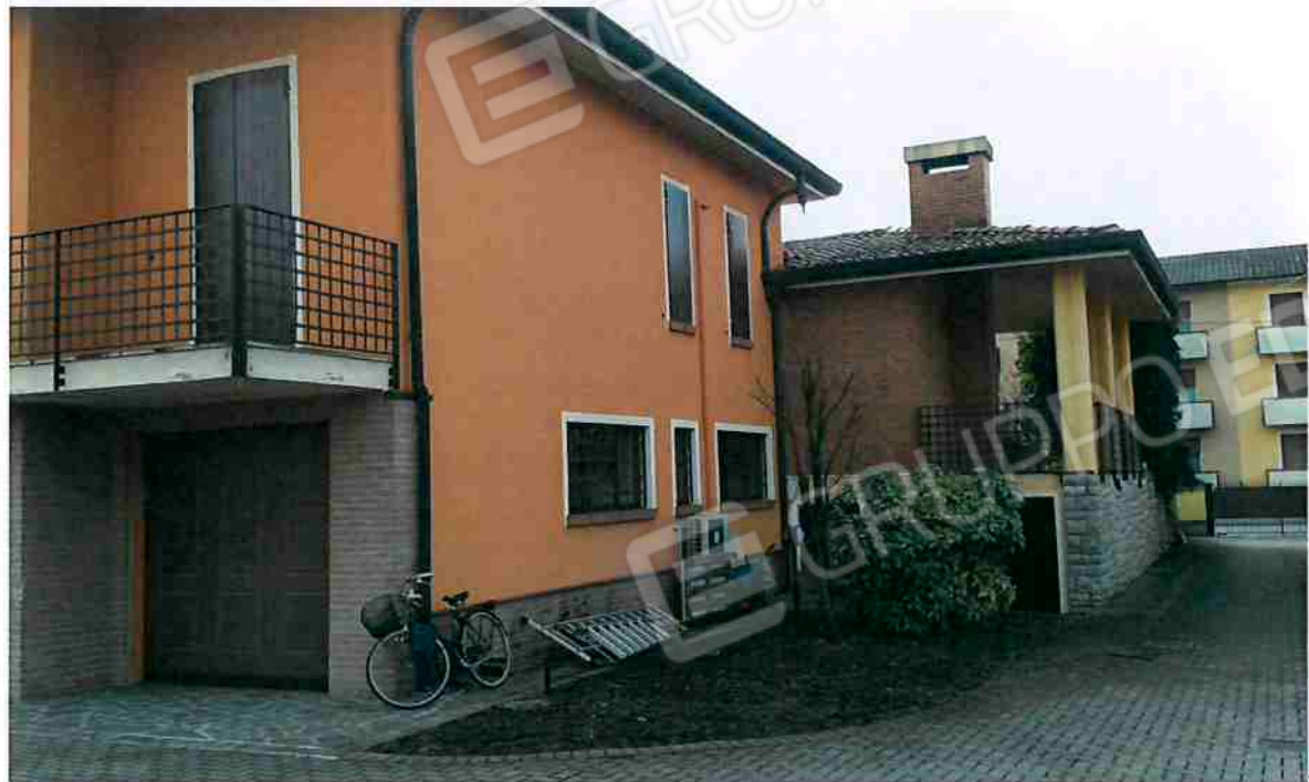
Vista esterna CORTE INTERNA - fronte NORD-EST
