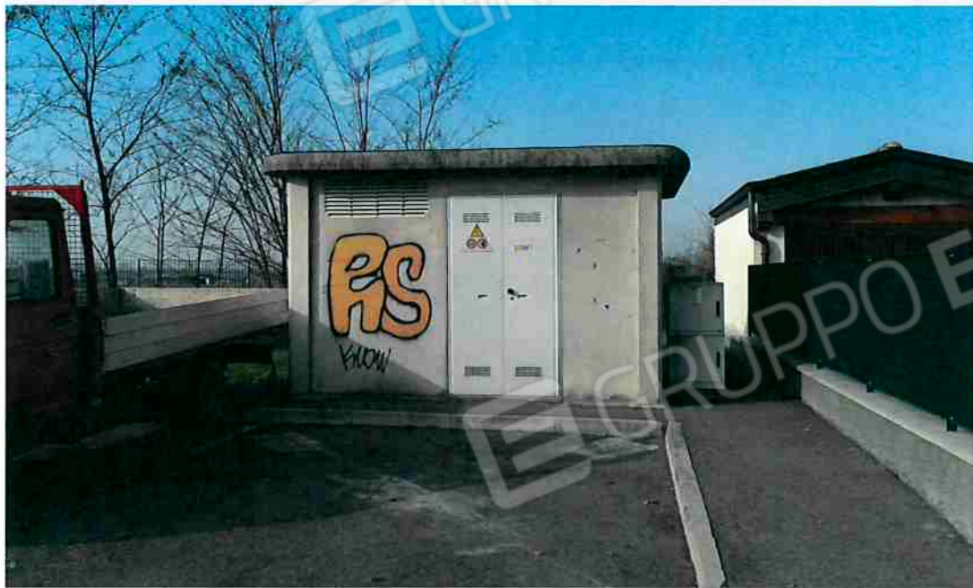
Vista esterna – CABINA ENEL n. 13
