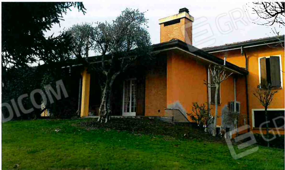
Vista esterna CORTE INTERNA - fronte SUD-EST
