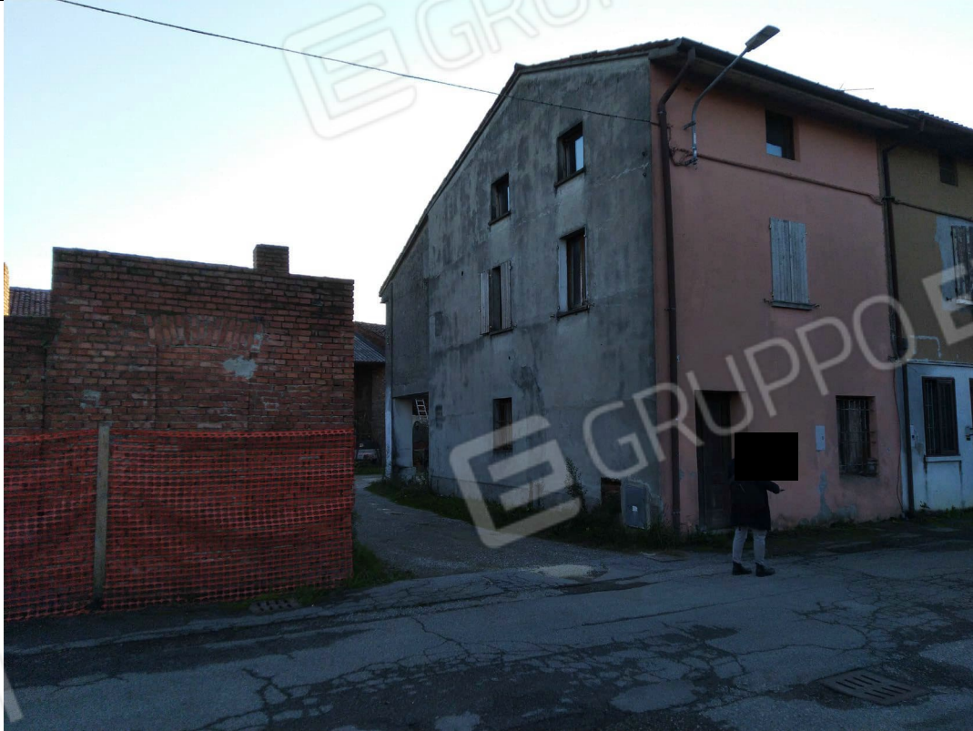
foto 1 – Vista d'insieme da strada
