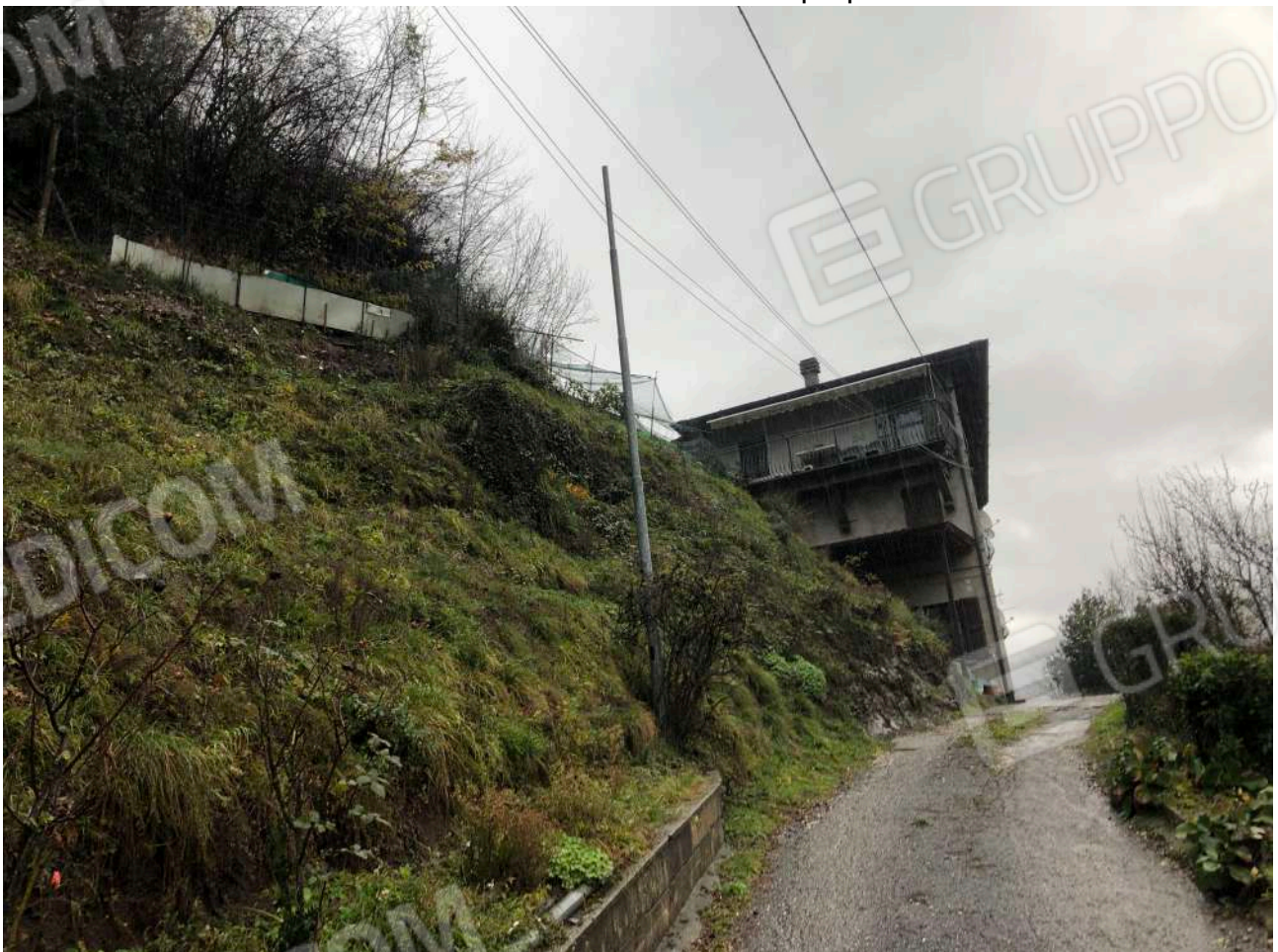
Foto n°20: Strata d'accesso alla proprietà
