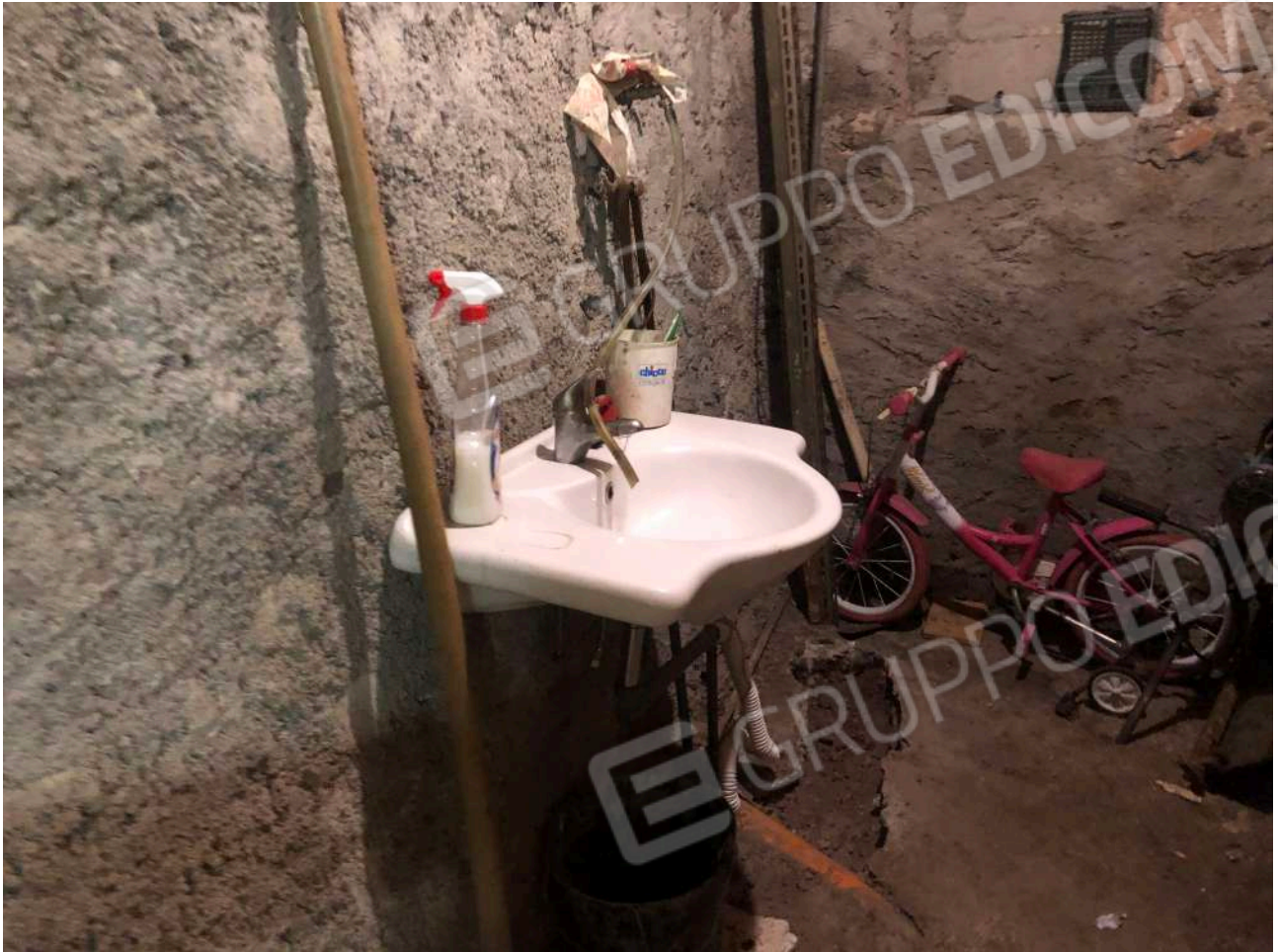
Foto n°15: Vista interna del disimpegno antistante il deposito n°2
