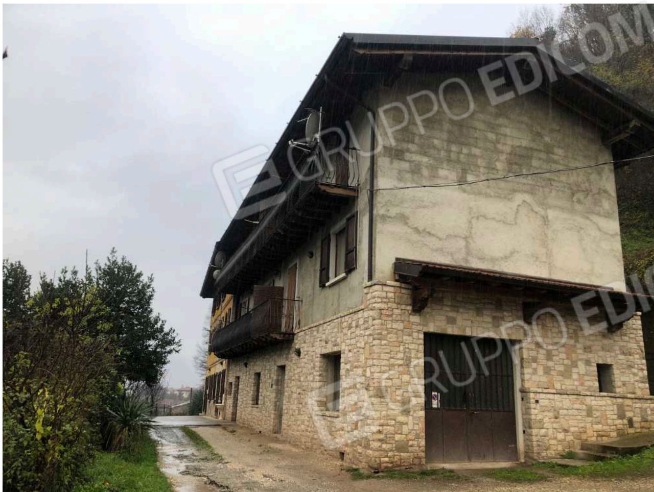
Foto n°3: Vista esterna del fronte nord del fabbricato
