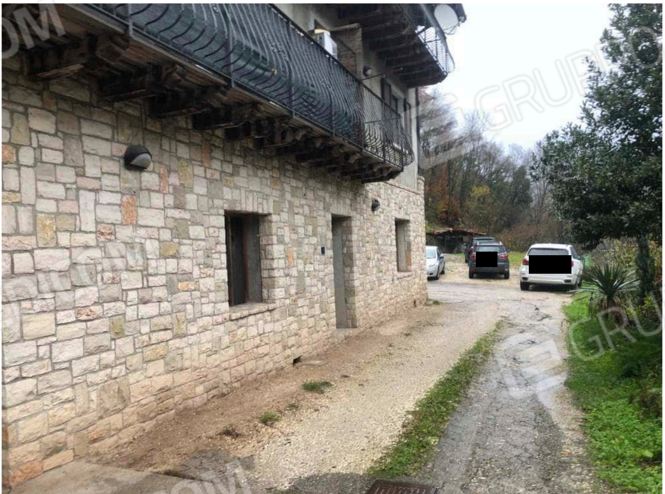
Foto n°2: Vista esterna del fronte est del fabbricato
