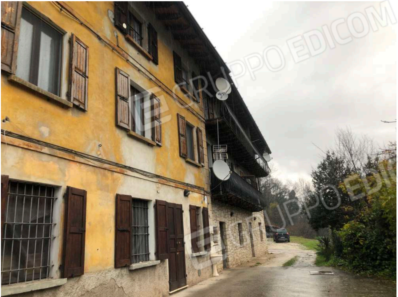
Foto n°1: Vista esterna del fronte est del fabbricato
