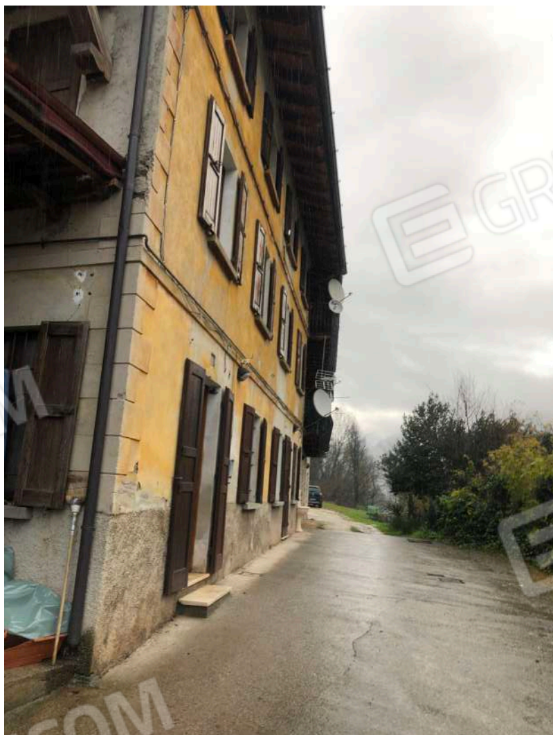
Foto n°2: Vista esterna del fronte sud-est del fabbricato
