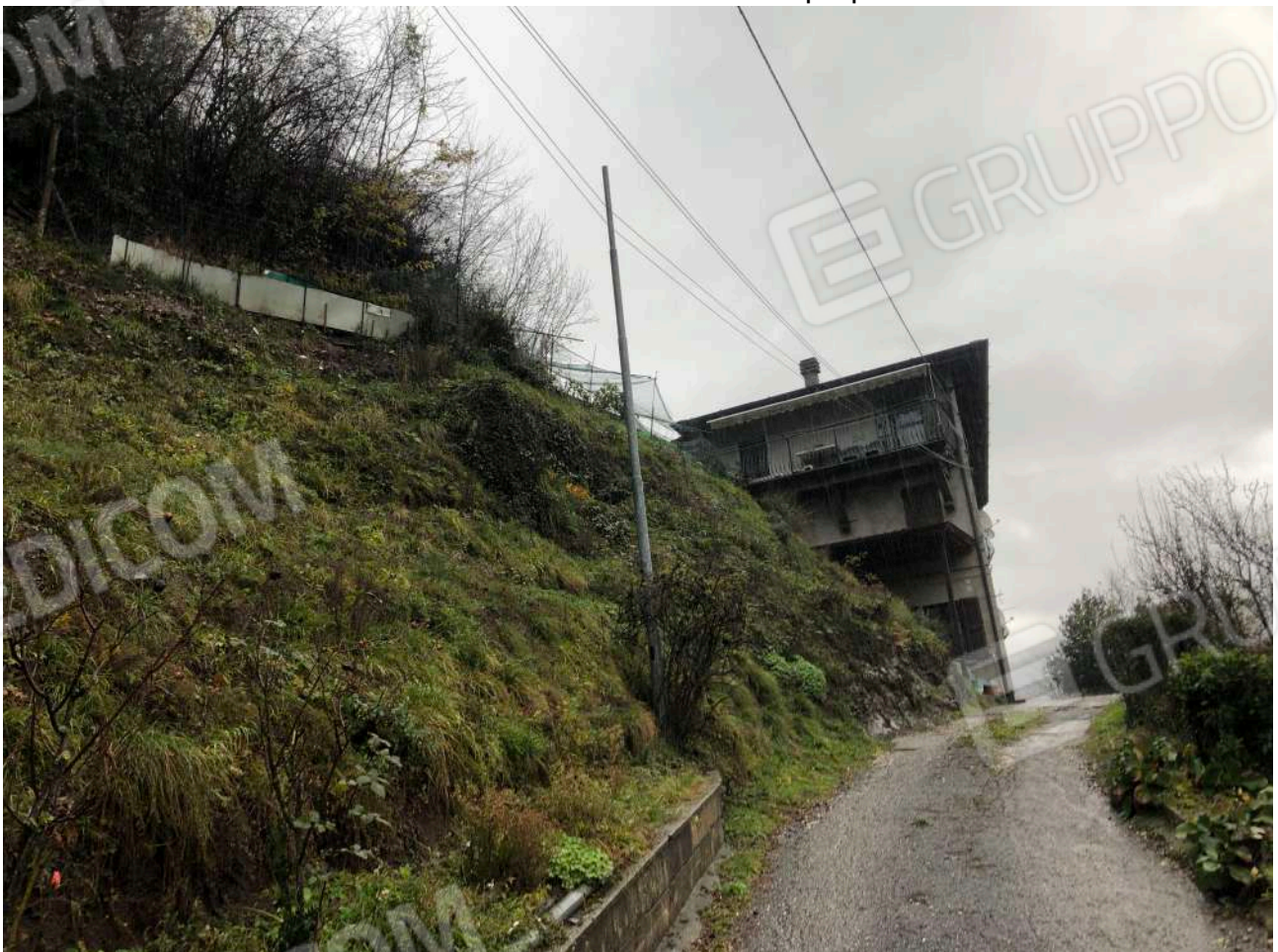
Foto n°20: Strada d'accesso alla proprietà
