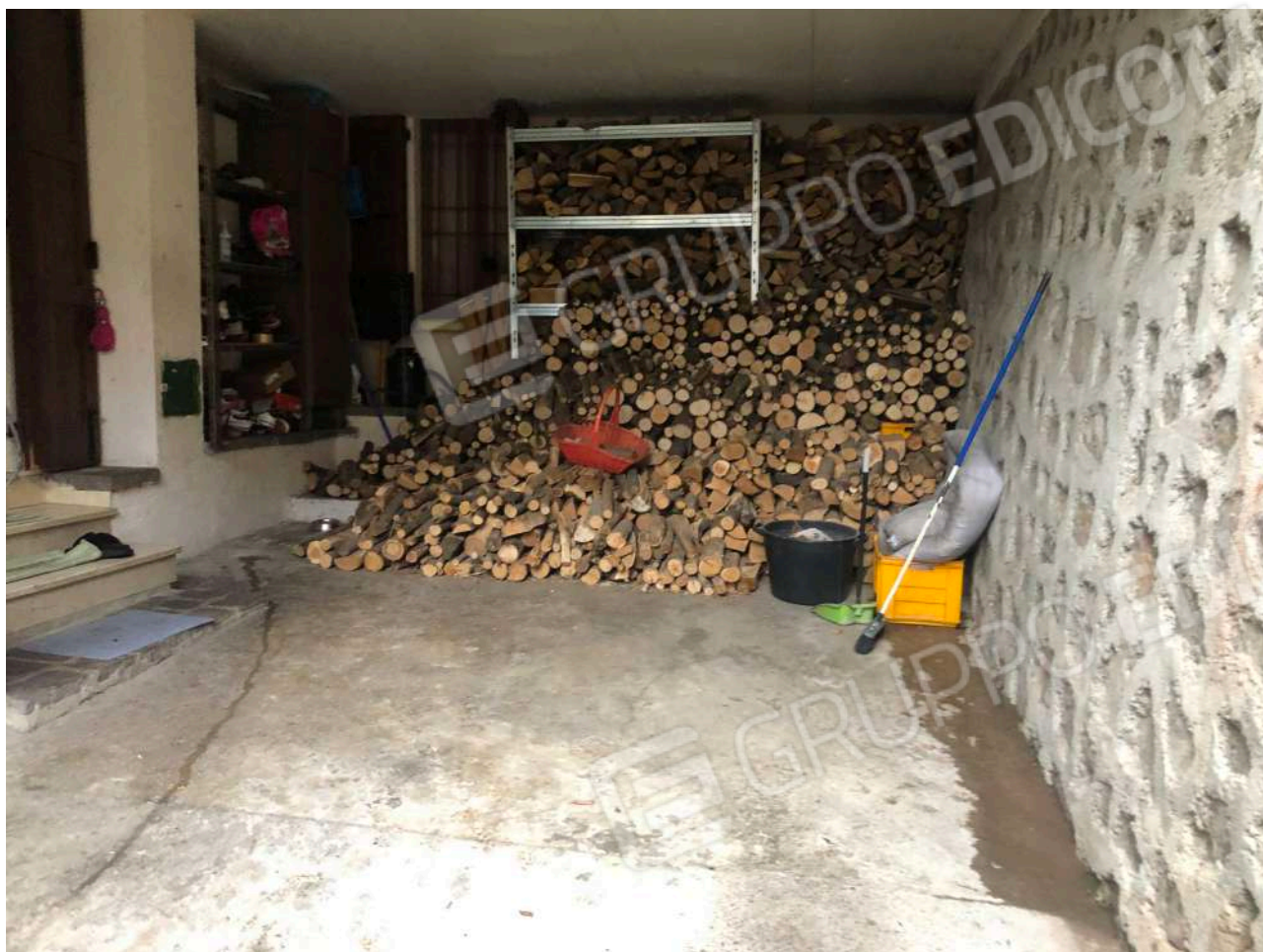
Foto n°5: Vista del portico adibito ad autorimessa
