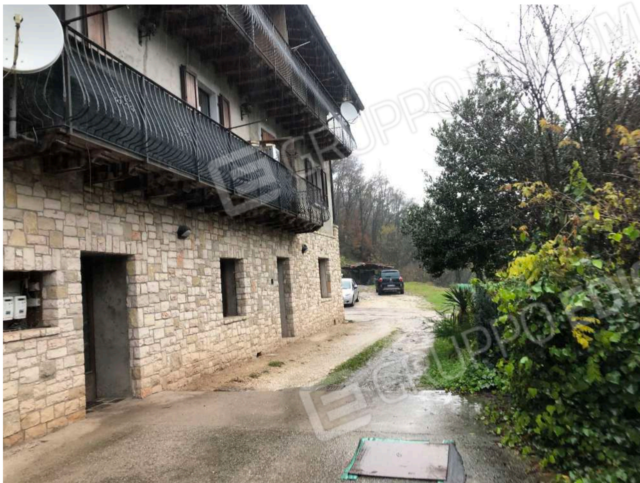
Foto n°21: Spazio antistante il fabbricato sul fronte est
