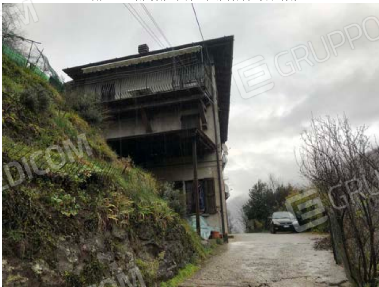
Foto n°2: Vista esterna del fronte sud del fabbricato
