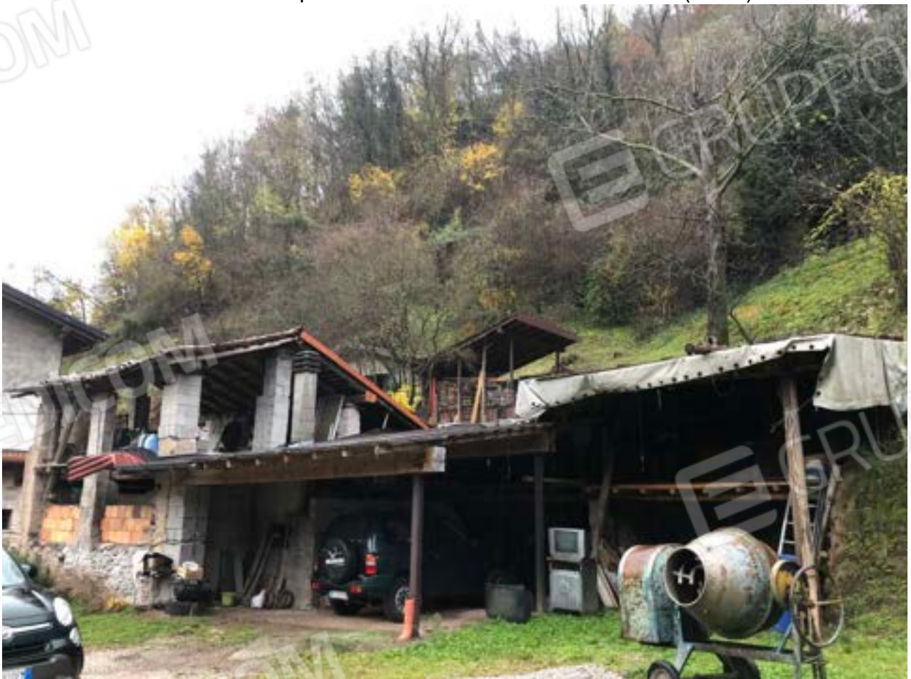
Foto n°24: Corpo di fabbrica n°1 con locali accessori (sub.4)
