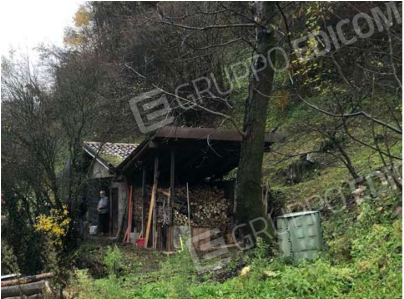
Foto n°31: Corpo di fabbrica n°2 con locali accessori (sub.5)
