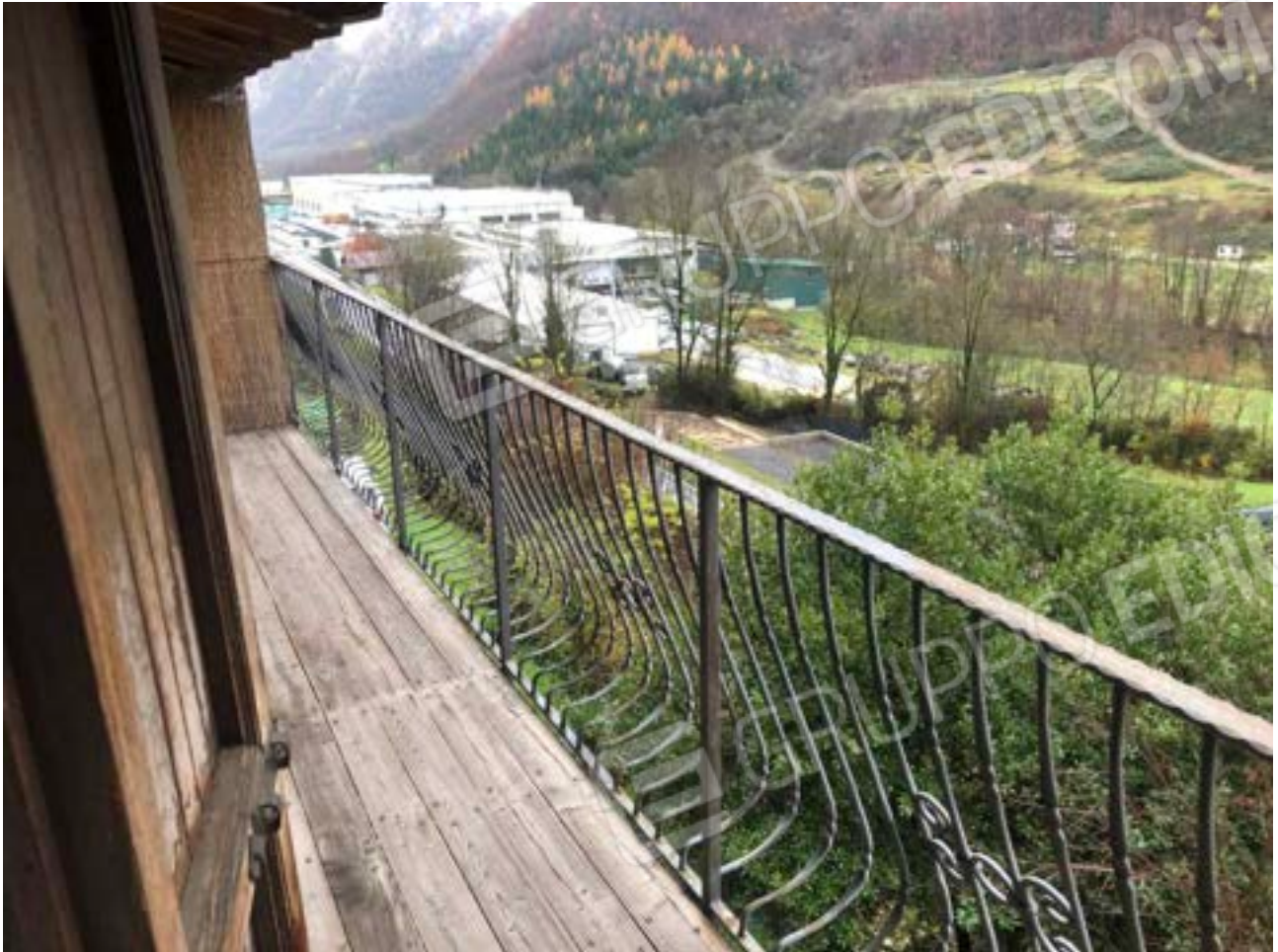
Foto n°7: Balcone posto sul fronte est
