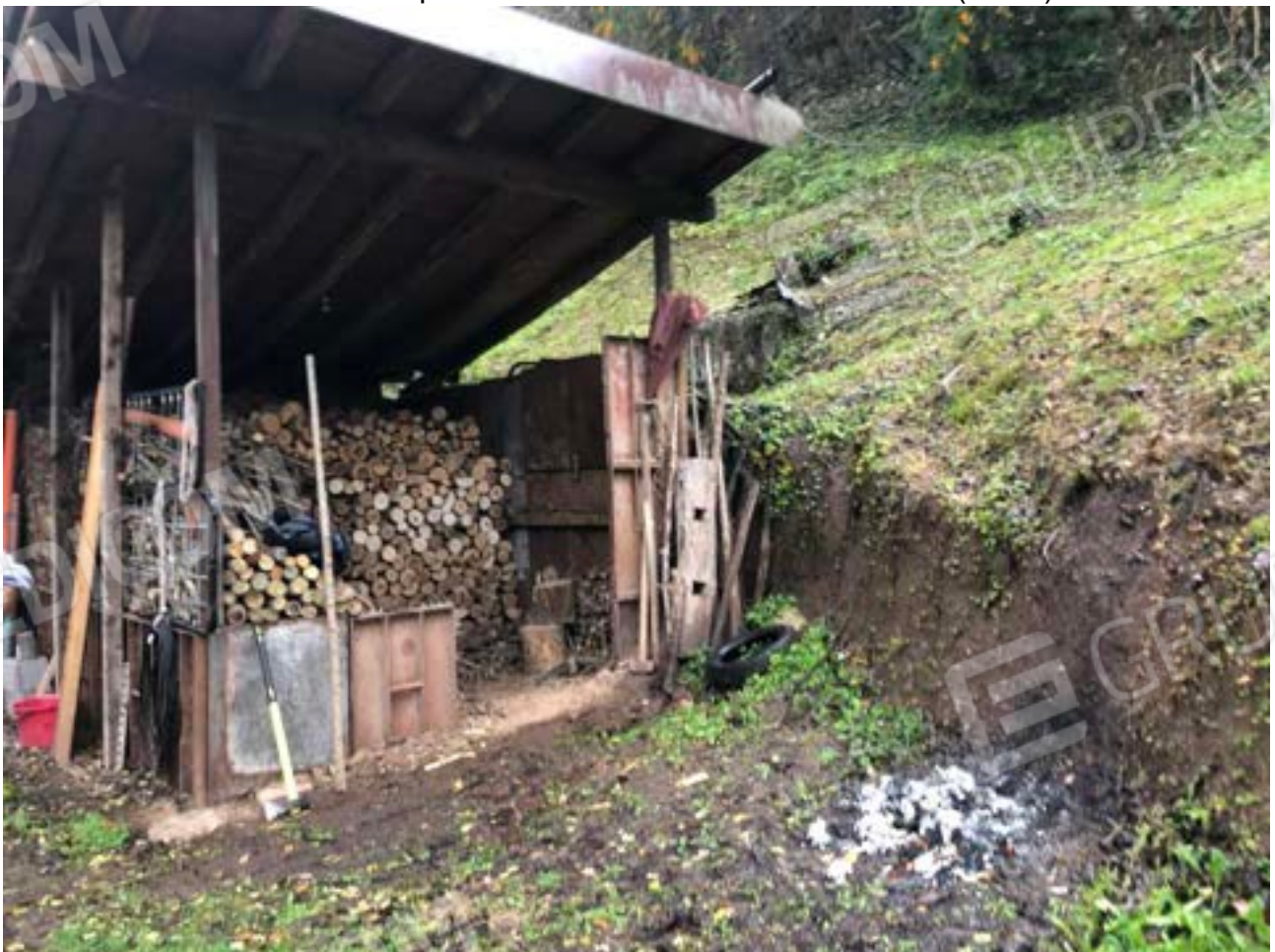
Foto n°32: Corpo di fabbrica n°2 con locali accessori (sub.5)
