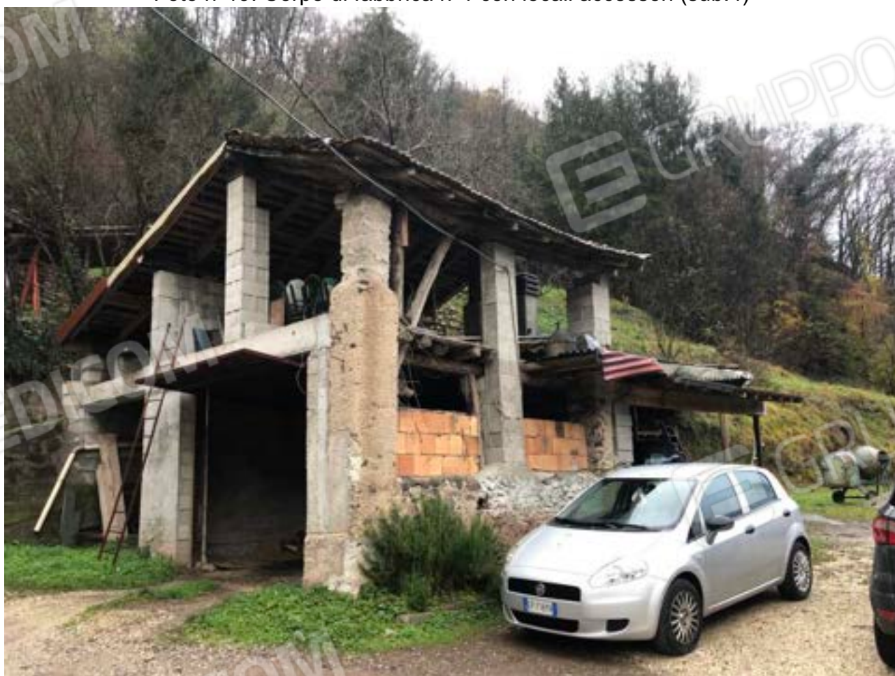
Foto n°20: Corpo di fabbrica n°1 con locali accessori (sub.4)
