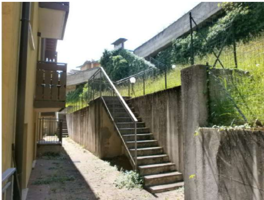
N. 11 - Vista scala di ingresso principale, lato ovest.
