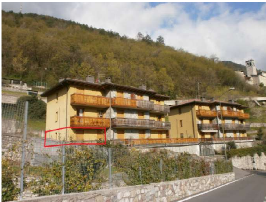
N. 7 - LOTTO 1 - Vista lati sud ed est.
