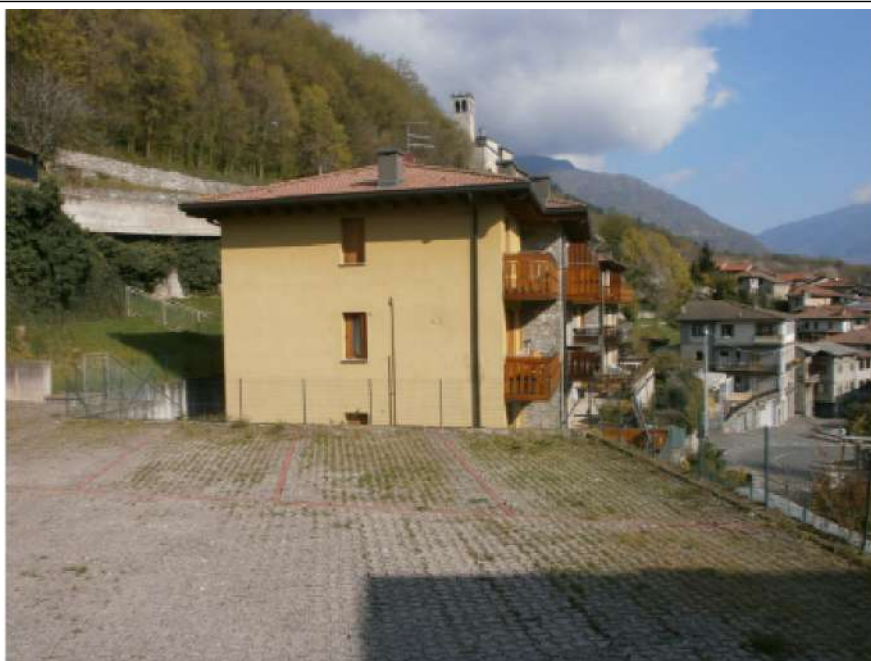
N. 6 - Vista lato sud, con parcheggio pertinenziale.
