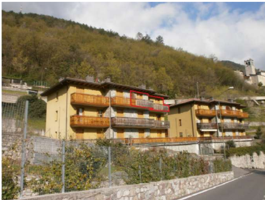
N. 5 - LOTTO 3 - Vista lati sud ed est.
