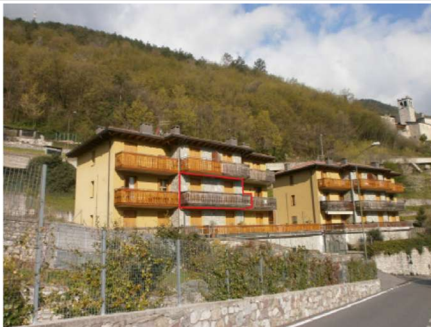
N. 8 - LOTTO 2 - Vista lati sud ed est.
