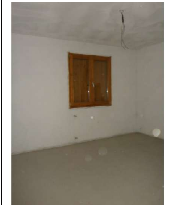
N. 40 - Sub. 32- Camera 2
