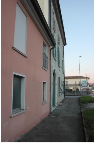
Foto 1 – Facciata laterale con ingresso su via Mazzini
