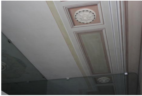
Foto 15 – soffitto camera sub. 9
