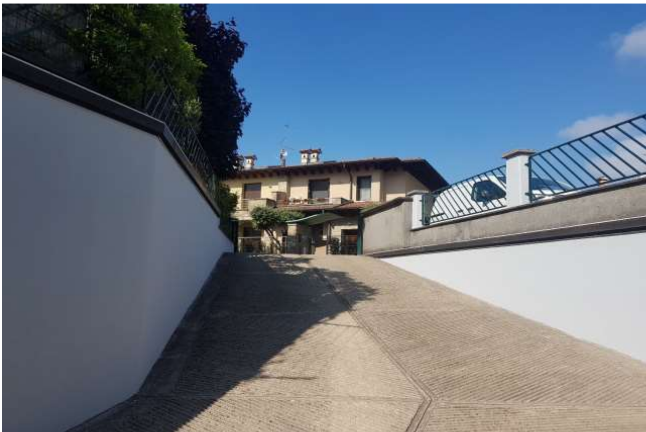
Vista rampa accesso interrato.
