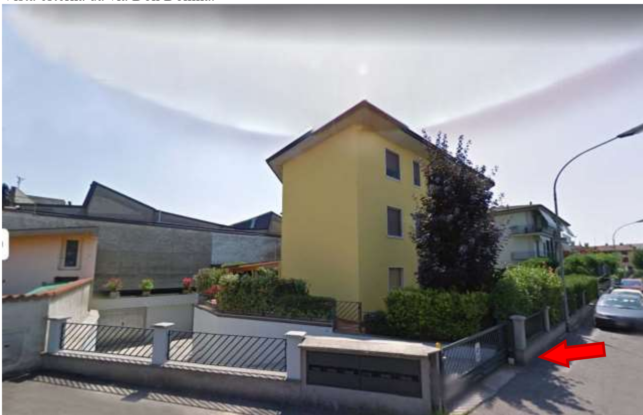
Vista accesso carraio di accesso al corsello interrato dello stabile.
