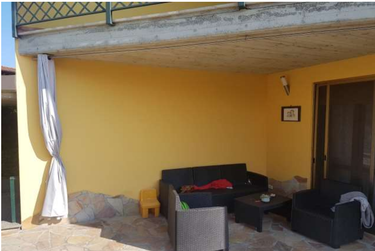
Vista portico a Sud dell'immobile.
