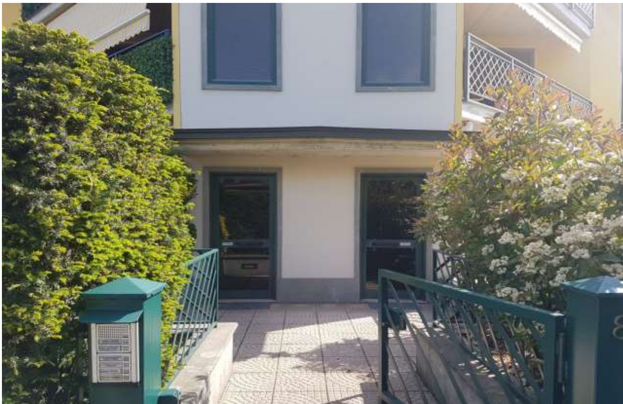
Vista portoni d'ingresso del condominio.
