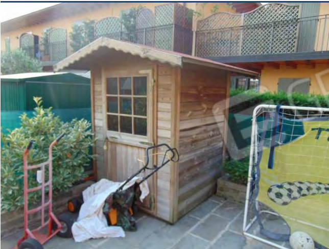
Difformità: casetta attrezzi nel giardino sul retro
