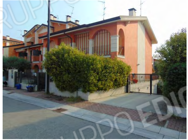
Vista da sud del bene e del cancello carraio comune
