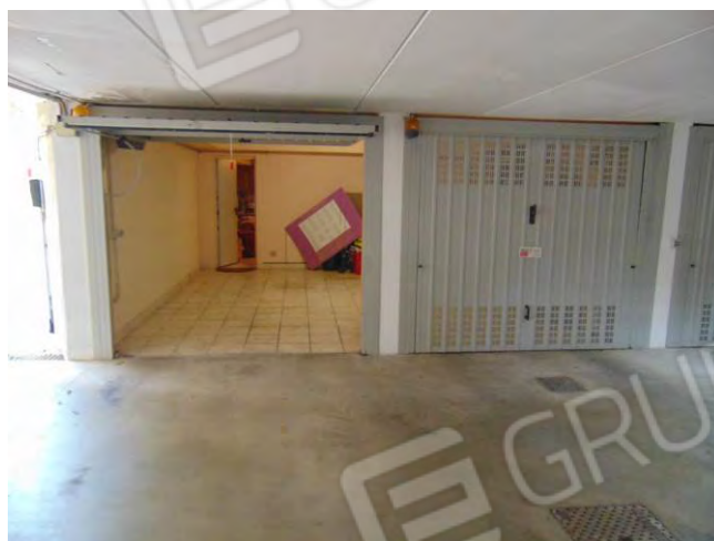
Piano interrato – accesso autorimessa visto da corsello comune
