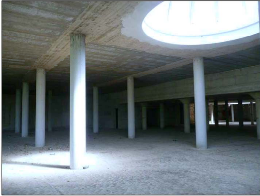
VISTA INTERNA VERSO LATO NORD-OVEST
