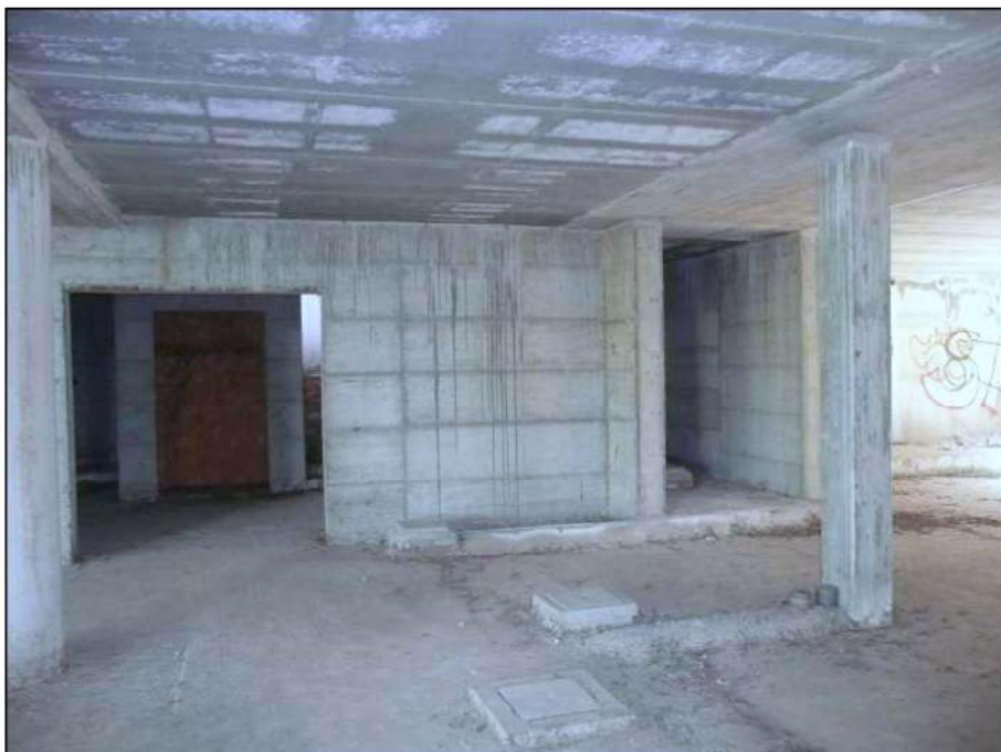
VANO SCALA LATO OVEST DA CUI SI ACCEDE ALLA COPERTURA
