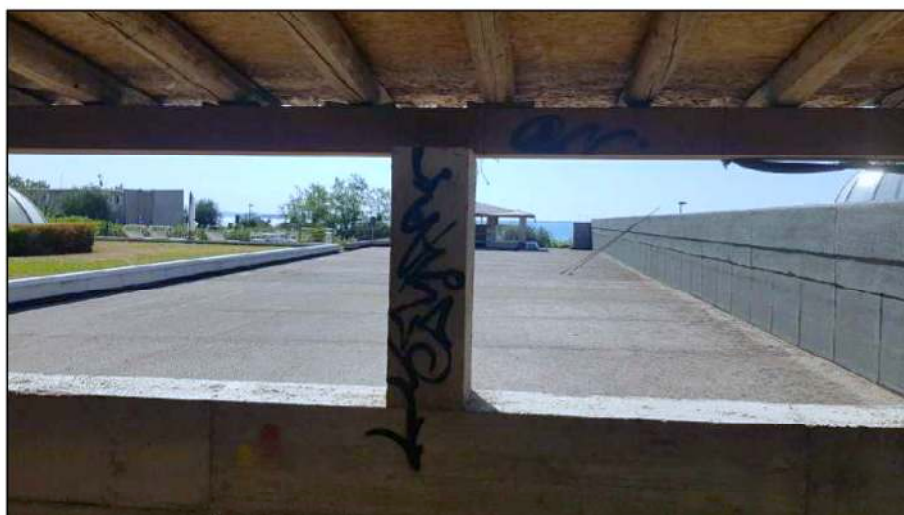
VISTA DEL MANTO DI COPERTURA ZONA EST
