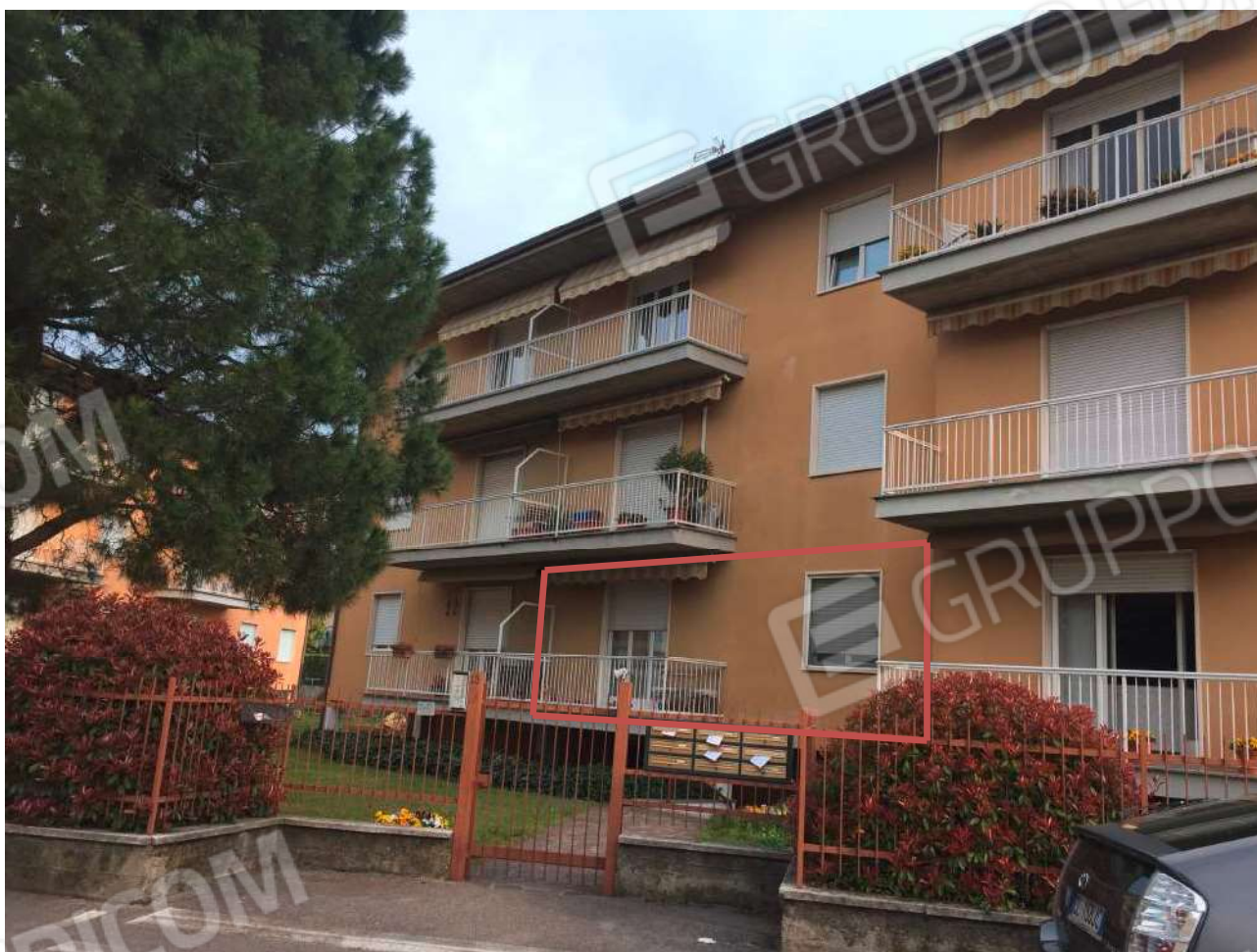
Ingresso su via Torquato tasso
