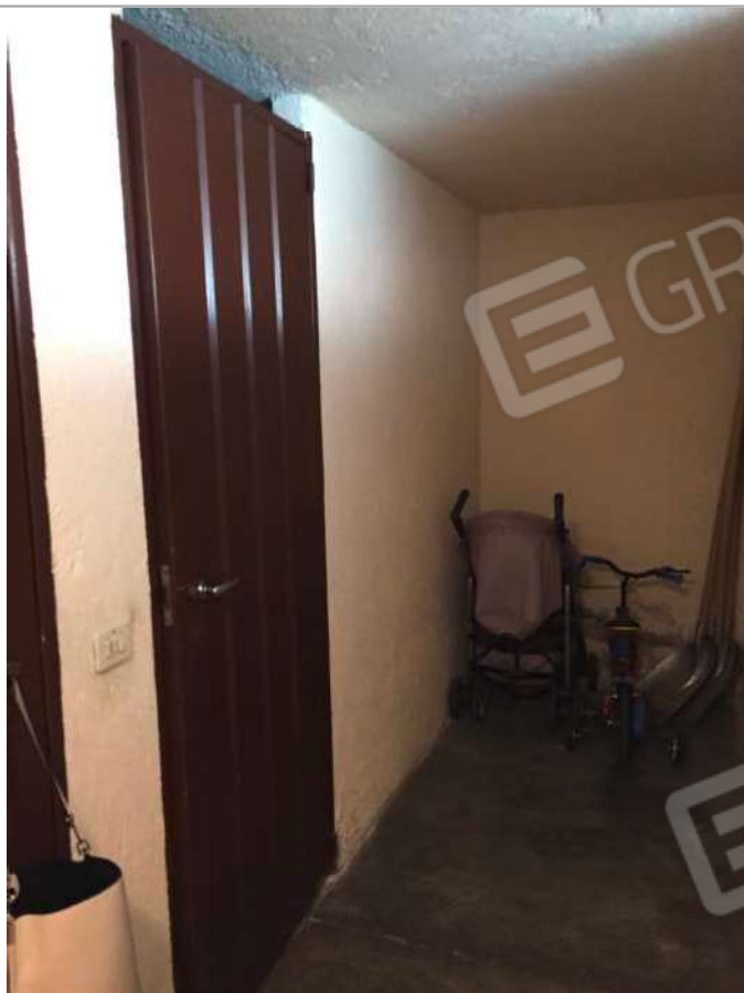
Corridoio seminterrato autorimesse
