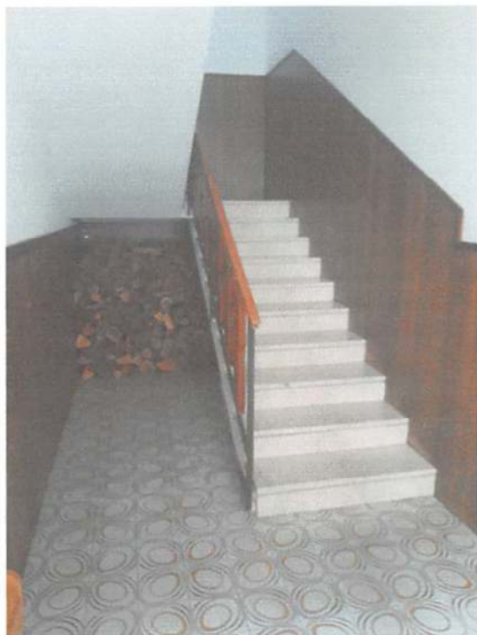
Scala accesso appartamento
