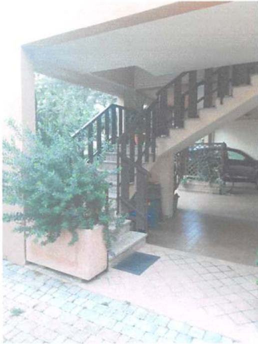
scala di accesso
