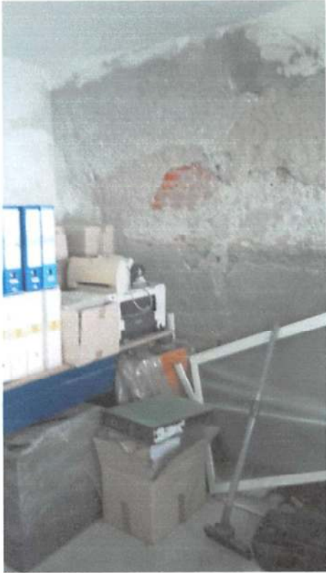
locali piano terra
