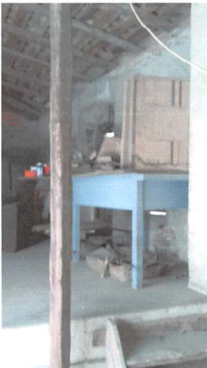
Magazzino piano primo
