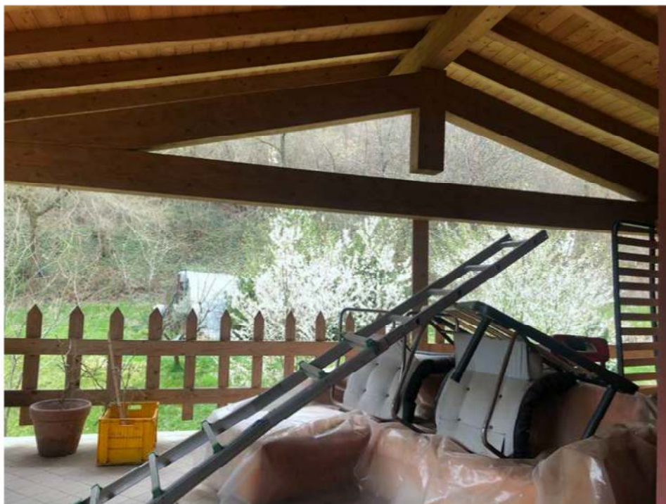
Foto n. 31 Loggia al primo piano
