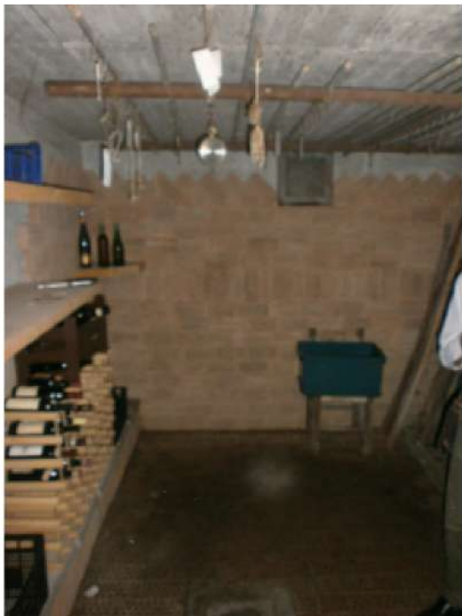
N. 28 - P. interrato: cantina
