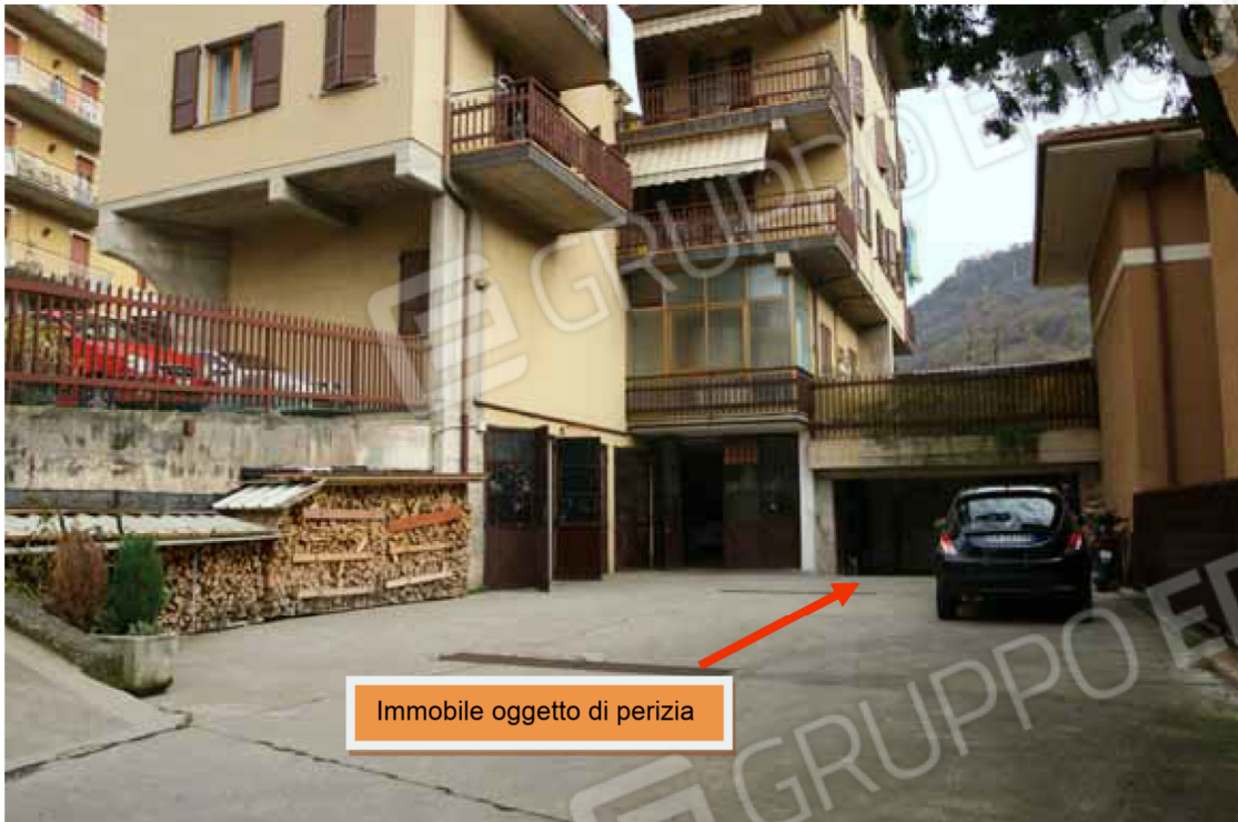
Vista dell'immobile dal cortile interno
