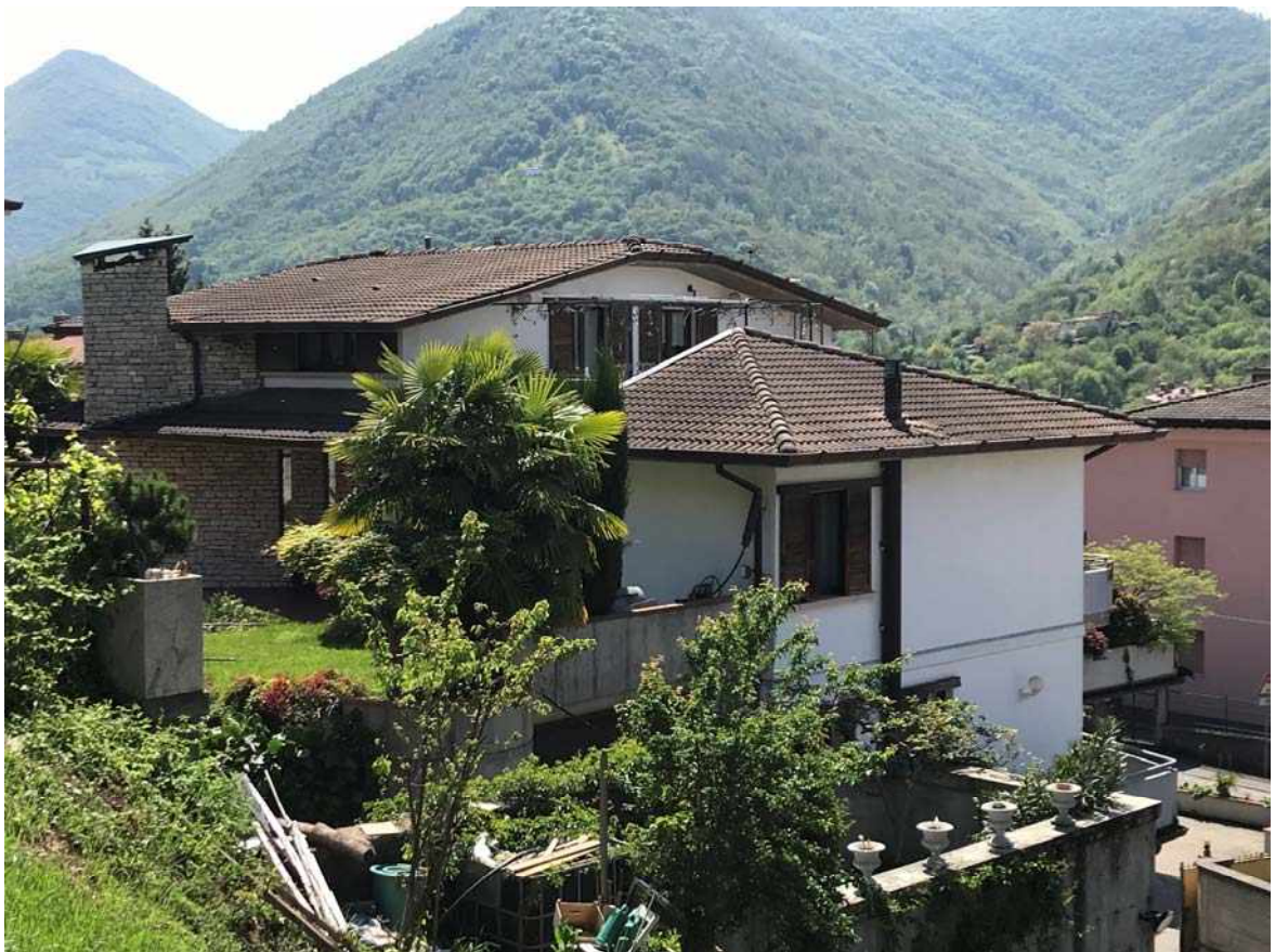
Vista lato nord-ovest dell'immobile
