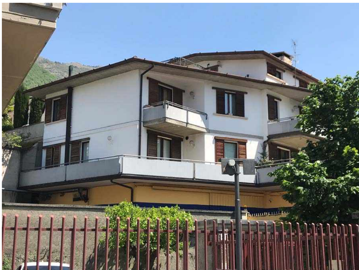
Vista lato sud-ovest dell'immobile
