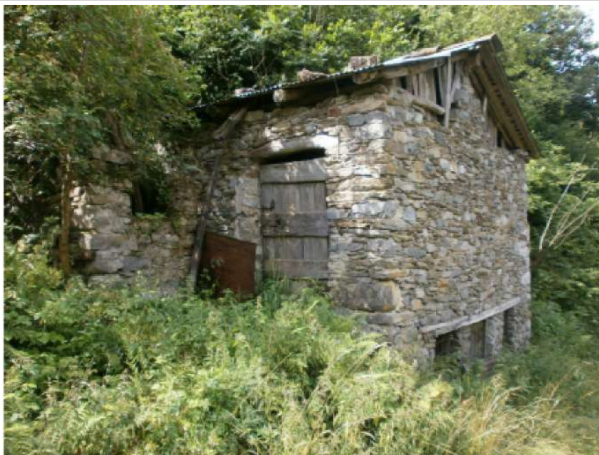
N. 12 - Dettaglio lato est.
