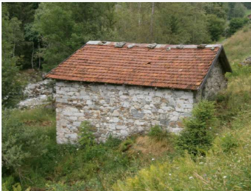
N. 12 - Vista lato ovest.
