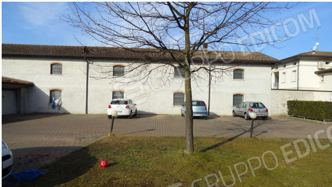
FOTOGRAFIA - N. 10 FACCIATA INTERNA OVEST COMPLESSO RESIDENZIALE
