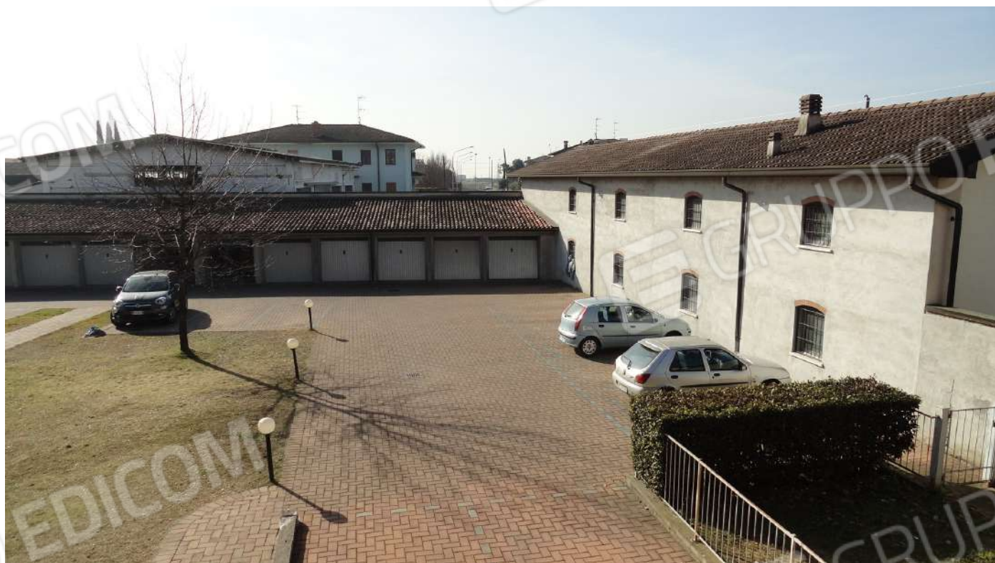
FOTOGRAFIA - N. 11 FACCIATA INTERNA SUD COMPLESSO RESIDENZIALE
