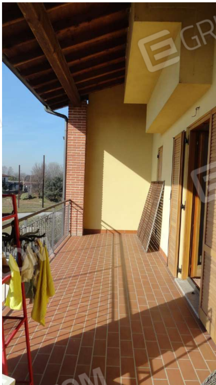
FOTOGRAFIA - N. 53 - LOGGIA /BALCONE AL PIANO PRIMO
