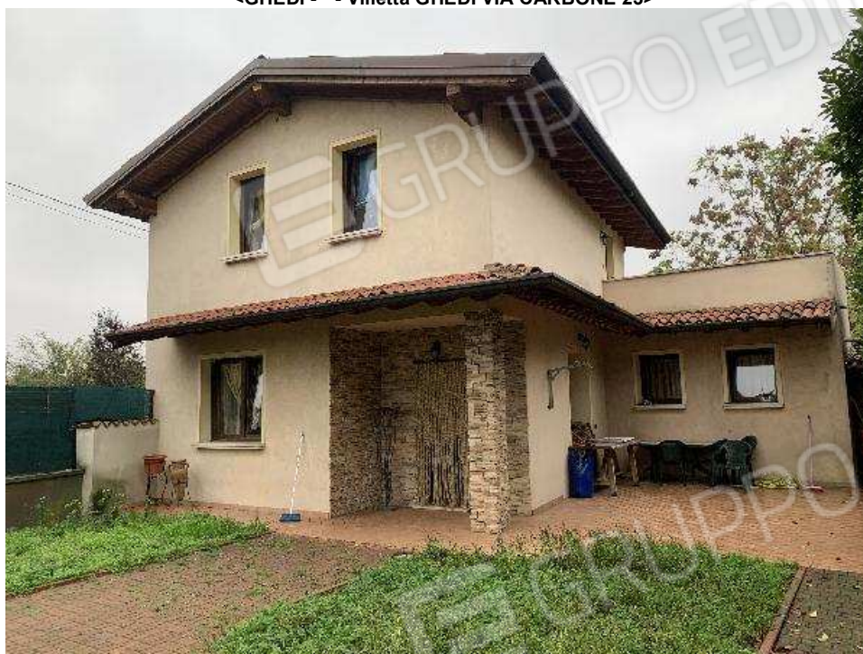
Villetta vista da nord - Sul cortile interno
