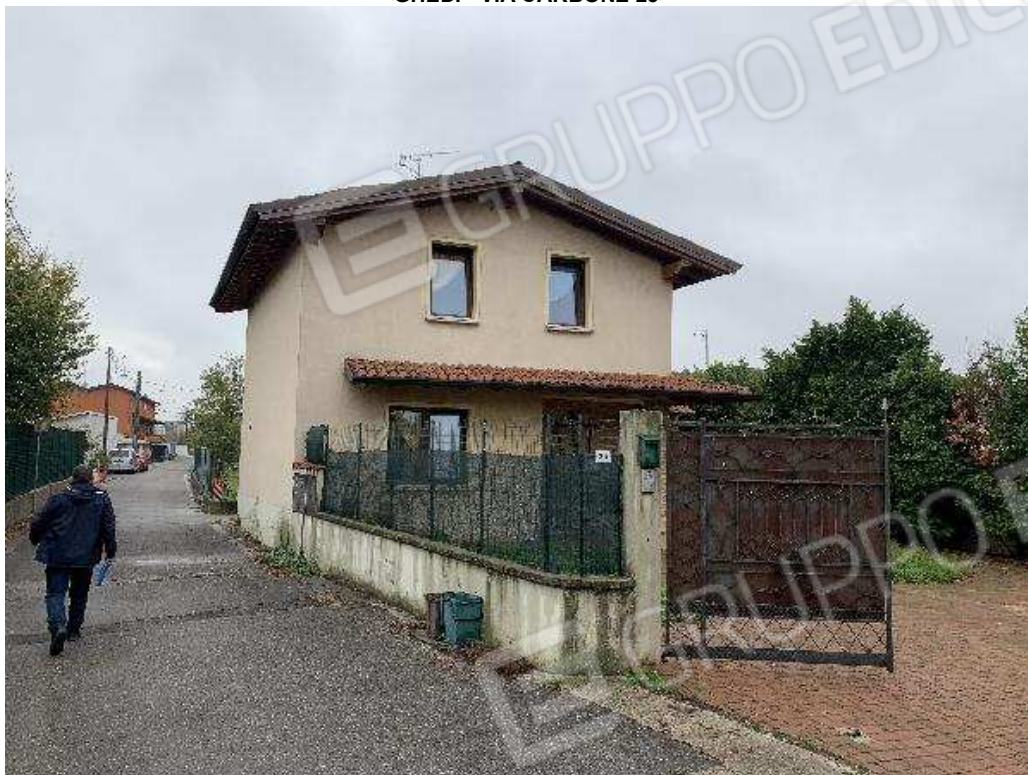
Villetta vista da nord - Via Carbone
