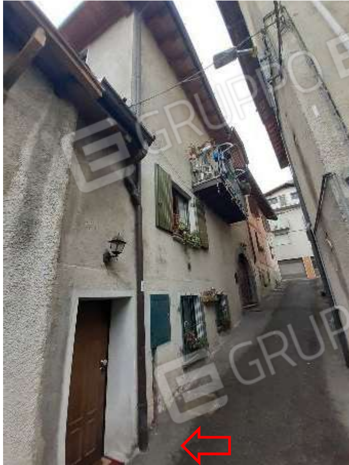
Ingresso alla cantina
