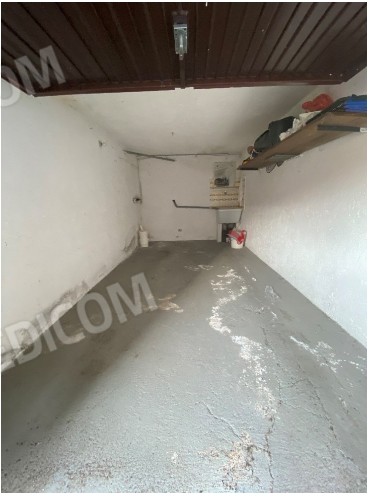
Autorimessa (vista interna)
