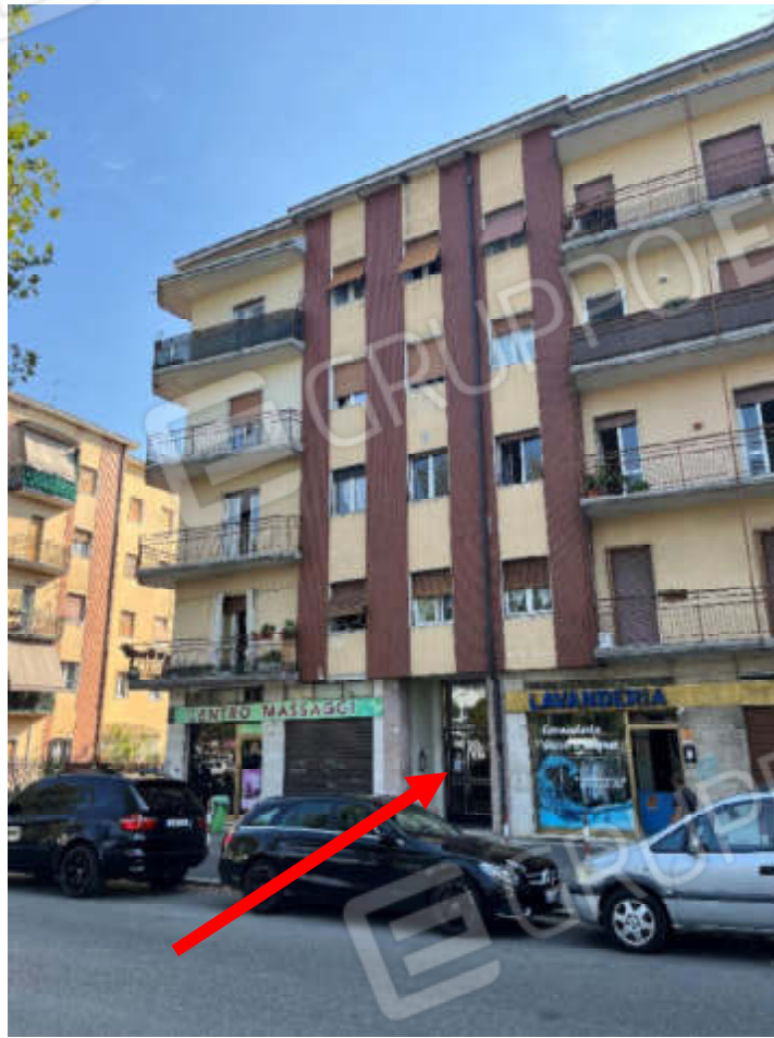
Accesso (vista da via Zamboni)
