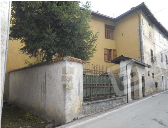
1 - Vista da Via Provinciale
