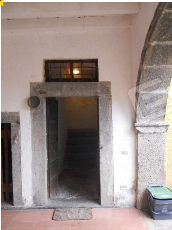
7 -Scala di accesso al piano primo dal portico
