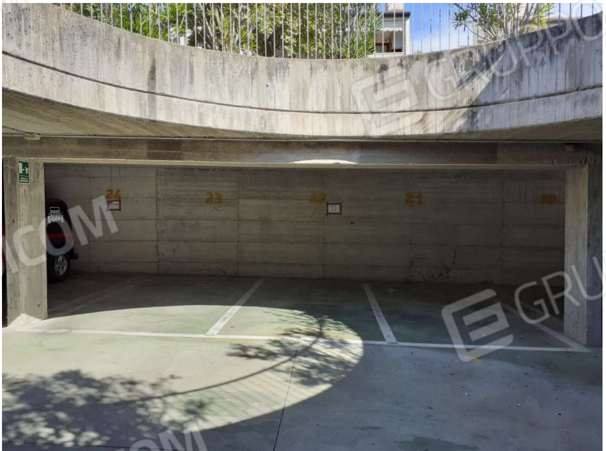
Posti auto 23 (sub. 36), 22 (sub. 37), 21 (sub. 38)
