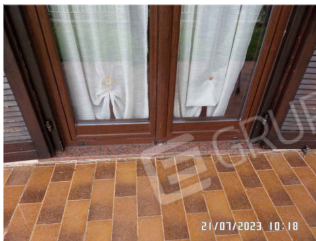
FOTO 45: Particolare ext. portafinestra cucina al p.1°
