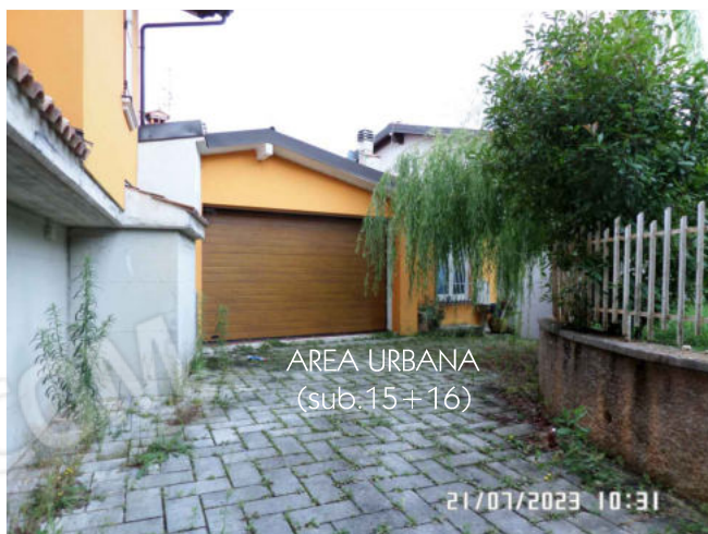
FOTO 13: Corte carrabile esterna alla recinzione
