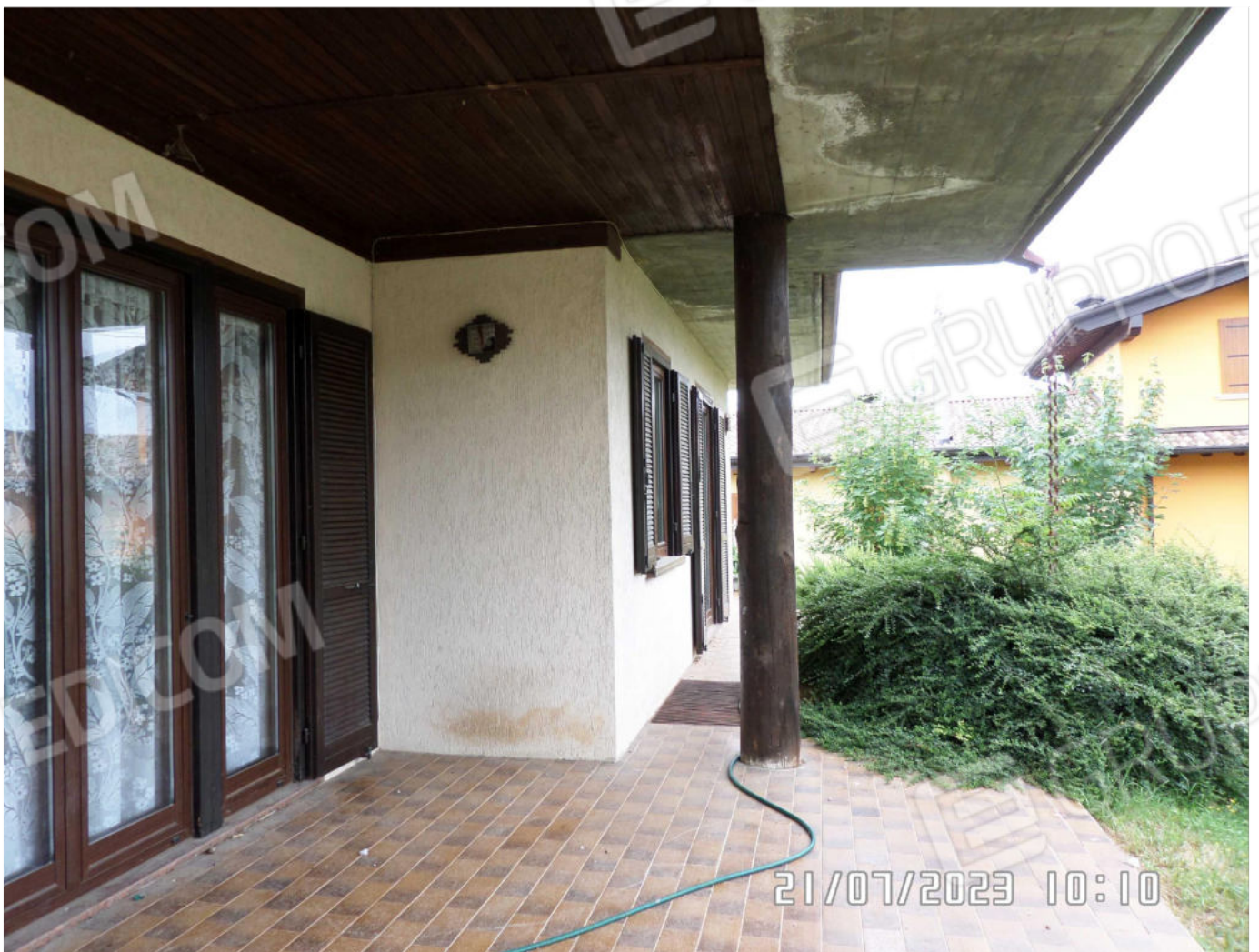
FOTO 10: Portico lato Sud e portafinestra del soggiorno
