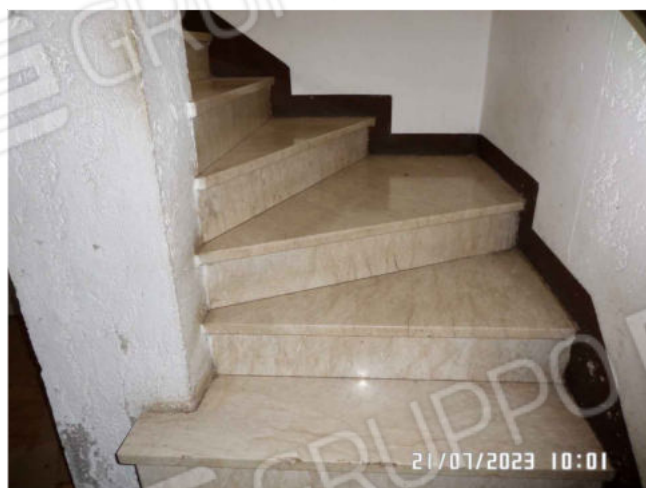
FOTO 31: Particolare dei gradini in marmo Botticino
