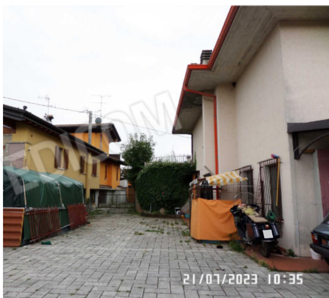
FOTO 15: Corte carrabile esclusiva ad Est della villa
