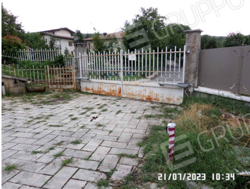
FOTO 4: Corte carrabile e lato interno del cancello con apertura automatizzata
