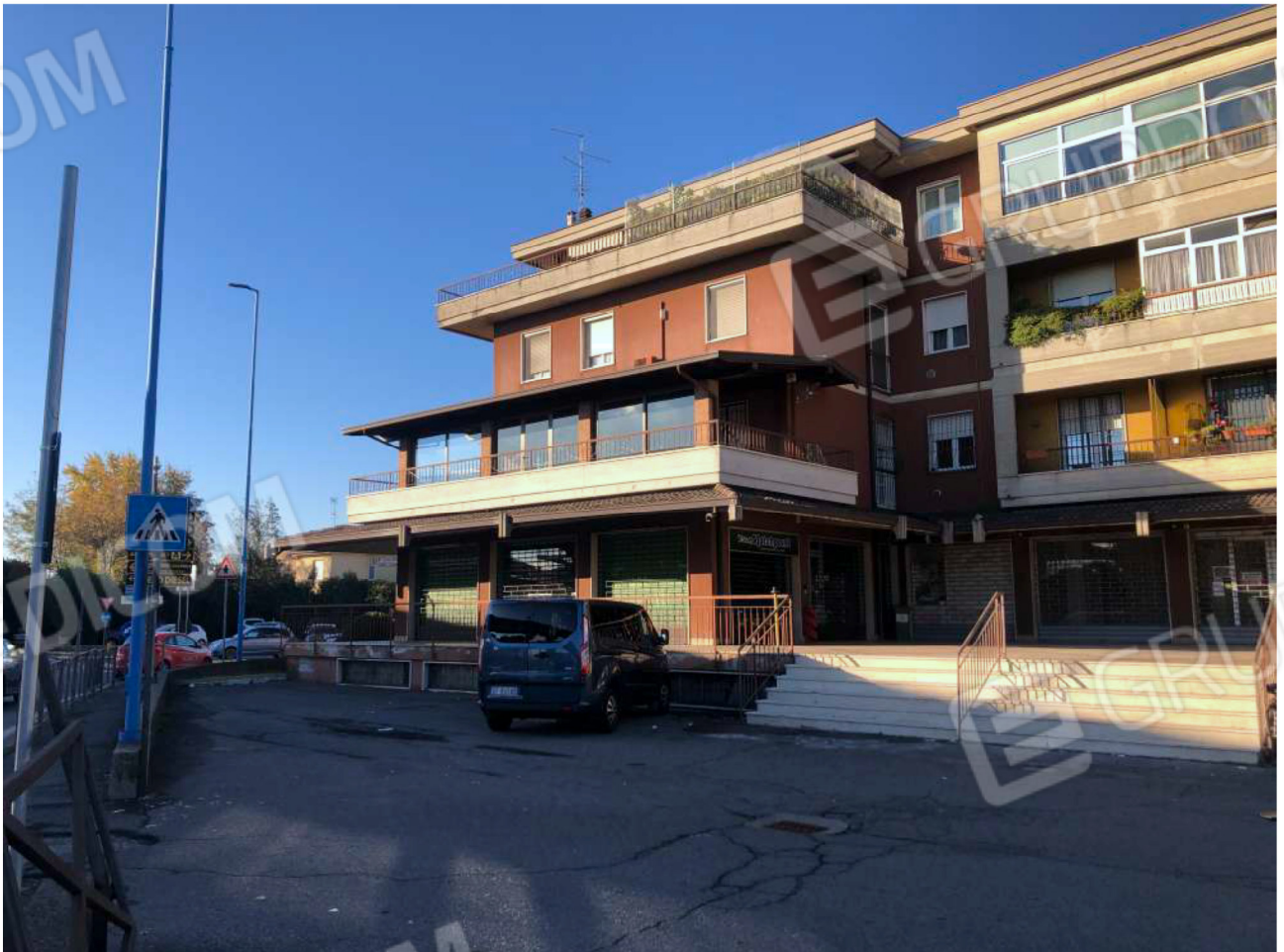
Foto n°2: Vista fronte est del fabbricato
