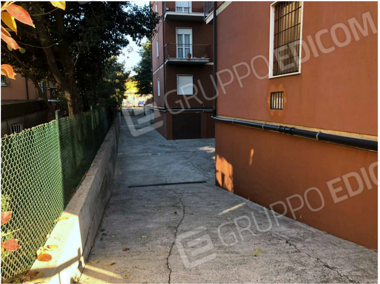
Foto n°23: Rampa d'accesso al cortile comune
