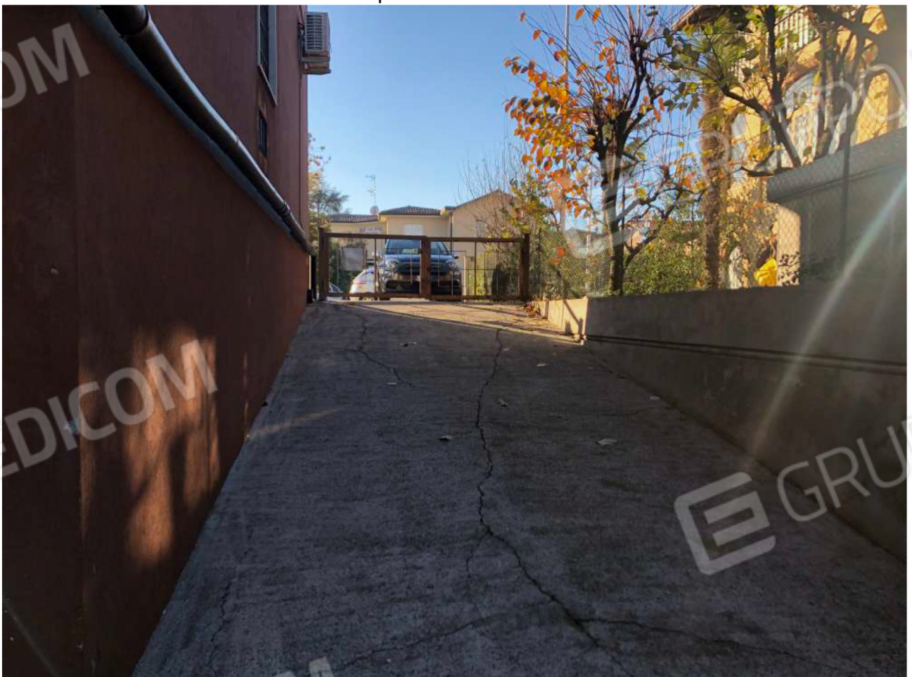
Foto n°24: Rampa d'accesso al cortile comune
