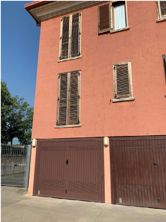
Prospetto retro con ingresso garage pertinenziale
