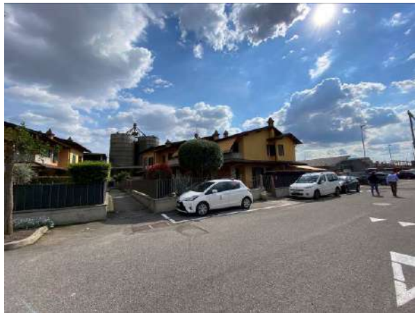
Fig. 03: Accesso pedonale da via dei Gelsi
